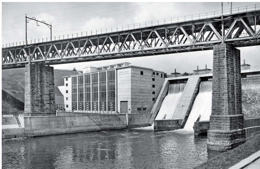
Bild 7: KW Wettingen in Betrieb 8.8.1933
