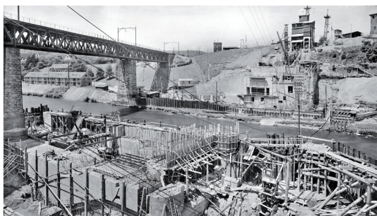
Bild 5+6: KW Wettingen im Bau März+Juni 1931
