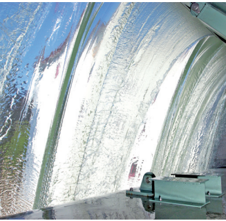
Bild 11: Überlaufklappe Wehrfeld
