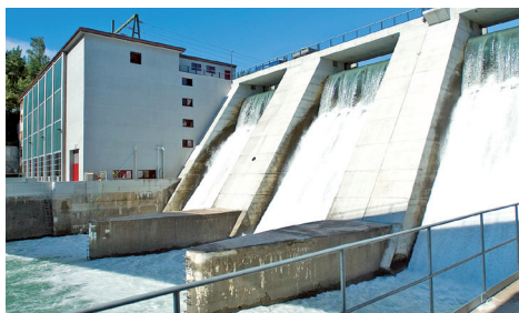
Bild 16: KW Wettingen mit Wehrfeld
