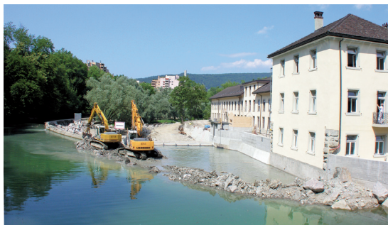
Bild 8: Sanierungsarbeiten am unteren Wettingerwehr Damsau 2006
