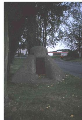
Es sind verschiedene Typen aus Stampf- oder Stahlbeton, seltener aus Stahl, bekannt, die sich auf Grundlage seinerzeit einheitlicher Richtlinien in der jeweiligen Ausführung unterscheiden. Entweder sind sie für die Aufnahme einer einzigen oder von zwei oder gar von drei Personen ausgelegt. Einer der renommierten Hersteller dieser Beton-Pilze war die Firma Beton-Brenner an der Maarstraße, Ecke Königswinterer Straße in Beuel.
