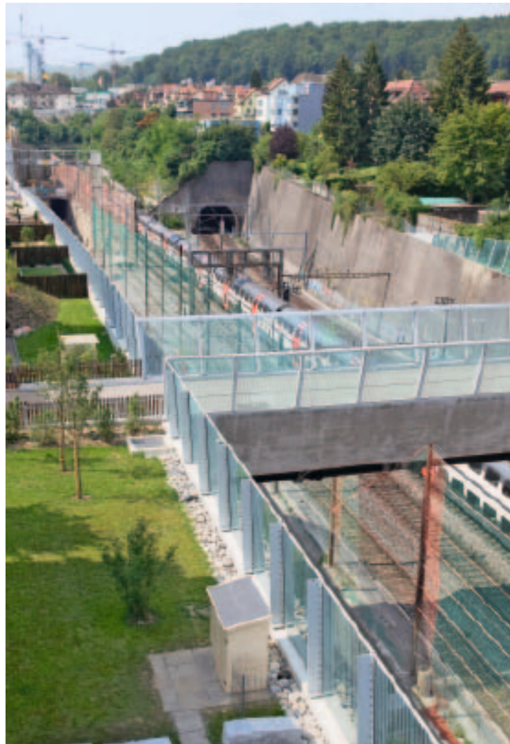
Lärmschutzwände in Zürich Oerlikon entlang der neuen Stützmauer und des Birchstegs.
