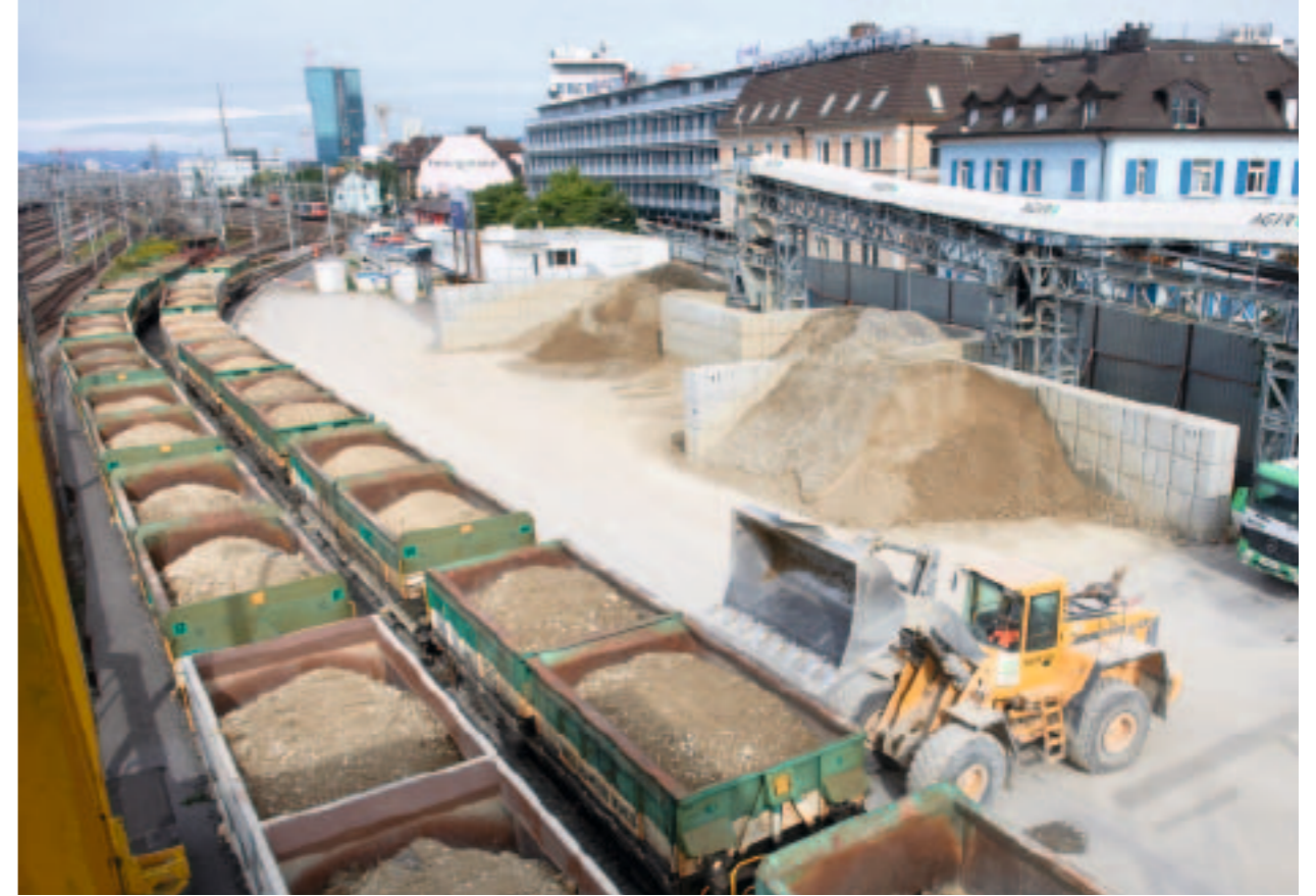
Täglich verlassen zwei Züge mit Aushubmaterial den Hauptbahnhof Zürich.
