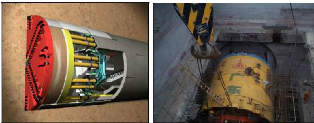
图 2.1-14 地下区间盾构施工示意图
