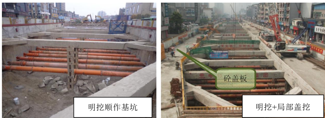
图 2.1-12 典型地下車站施工现场图
