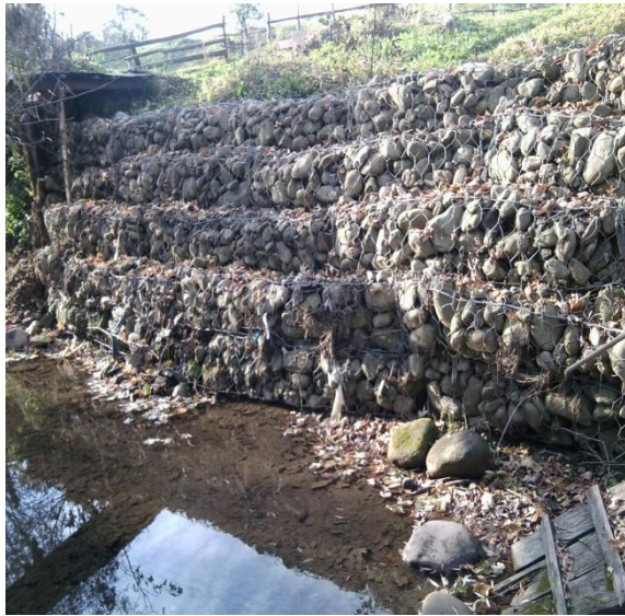
Укріплення берегів річки після наводка 2008 року
