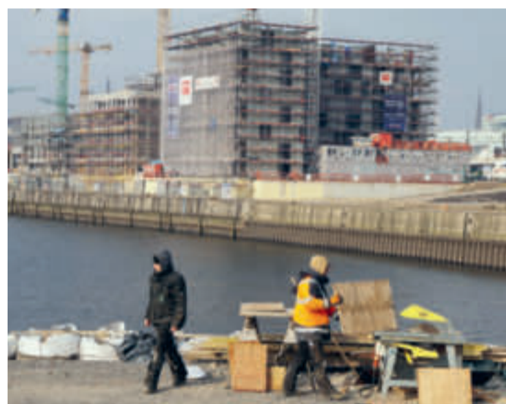
↑ Arbeiter im Baakenpark, im Hintergrund die ersten Hochbauten des Quartiers (Foto: Thomas Hampel)
