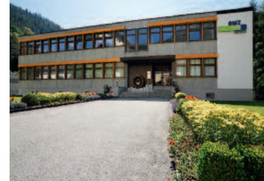
Betriebsgebäude in Sils.
