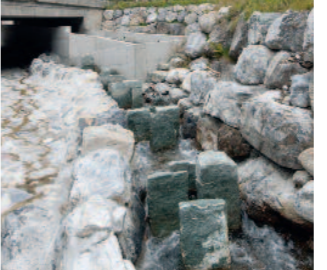
Fischtreppe bei Wasserfassung Heidbach.
