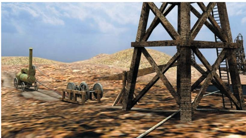
Бурение скв. 5 при помощи локомобиля. От эксцентрика бурового станка через балансир усилие передавалось на штанги, соединенные с долотом. Виртуальная реконструкция, 2008 г.
