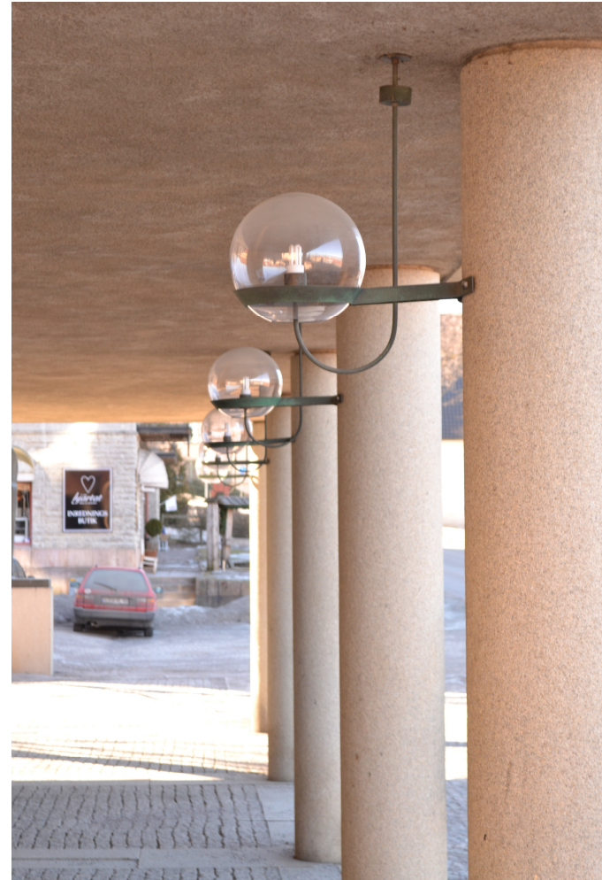
Bild 29: Armaturerna har en ovanligt elegant lösning av genomföringen för elledningarna.
