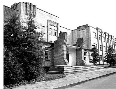
Рис. 6. Новый корпус на полигоне сельхозмашин. БГСХА, 2009 г.
