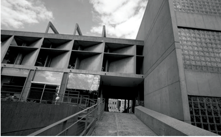
Görsel 6. Le Corbusier, 1961-1964, Carpenter Görsel Sanatlar Merkezi. Fondation Le Corbusier. Erişim: 24.09.2015. http://www.fondationlecorbusier.fr
