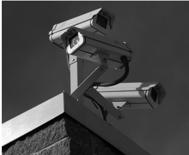
Slika 4: Nadzorne kamere na strešnem vogalu stavbe
