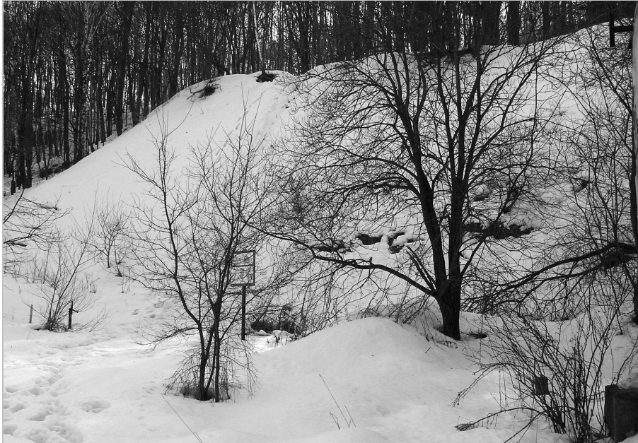
Rys. 5. Zasypany wylot sztolni Krystyna w Gwoźdźcu Fig. 5. The collapsed Krystyna adit mouth in the Gwoździec area
