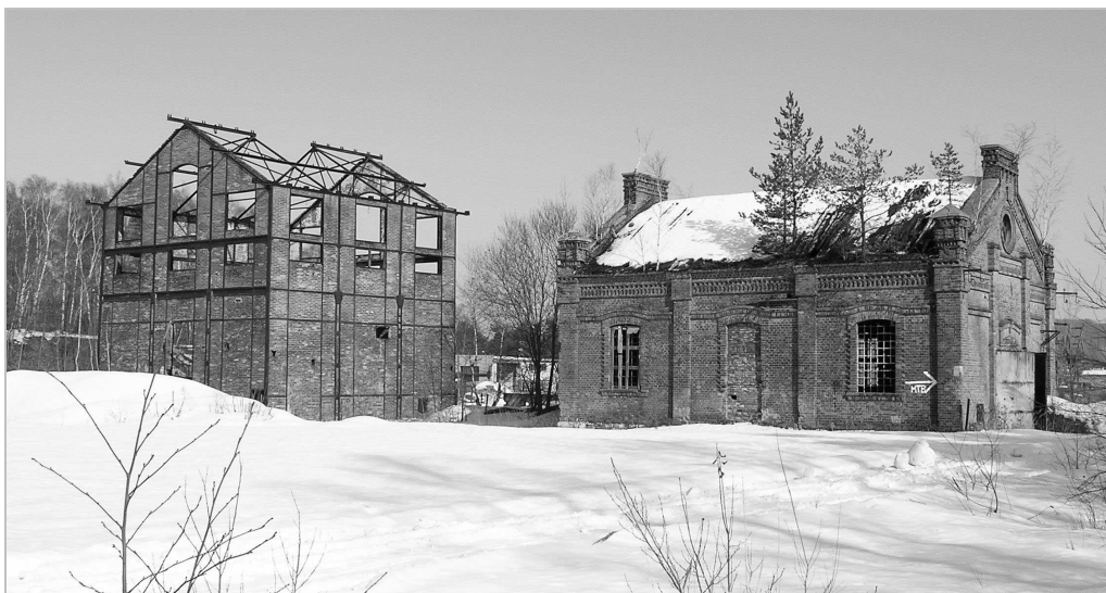
Rys. 4. Budynki nadszybia szybu Krystyna Fig. 4. Relicts of the Krystyna shaft buildings
