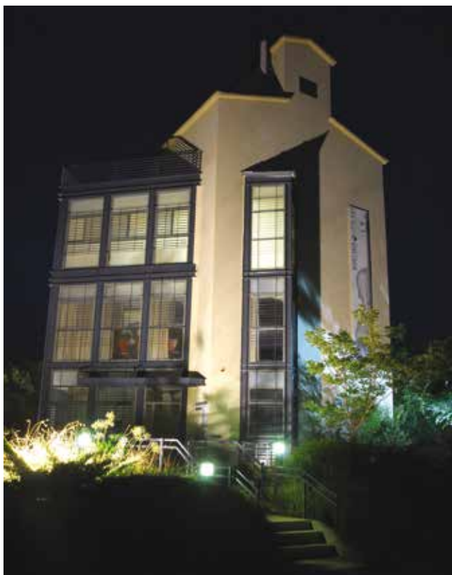
איור 6. תוספת בנייה ותצפית. קשת אילון, מרכז למוסיקה
