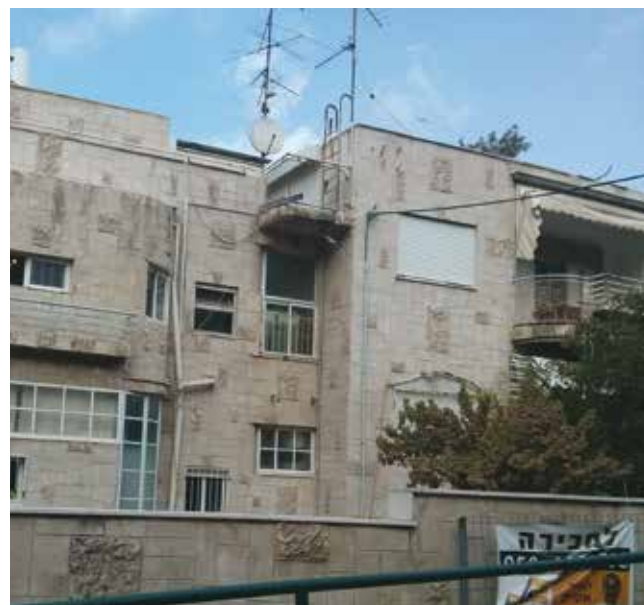
איור 2. תיאודור מנקס, בית אברמסון, 1938, חיפה. צילום: צפריר פיינהולץ, 2014
