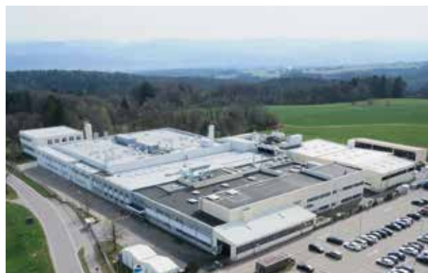
Ein Drittel weniger Energie benötigt der Freudenberg-Standort Görwihl-Oberwihl nach den umfassenden Modernisierungsarbeiten der vergangenen 3 Jahre.
