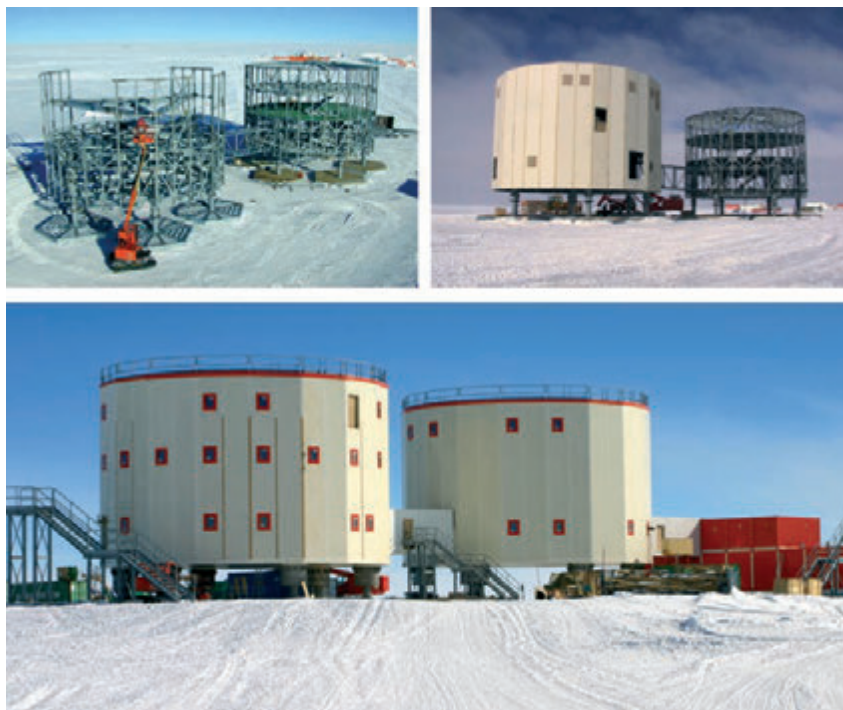
Fasi del montaggio della Base Concordia
