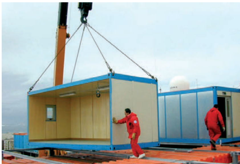
Stazione Mario Zucchelli, lavori di posa in opera dei moduli abitativi per la sopraelevazione, al centro l'Ing. Umberto Ponzo
