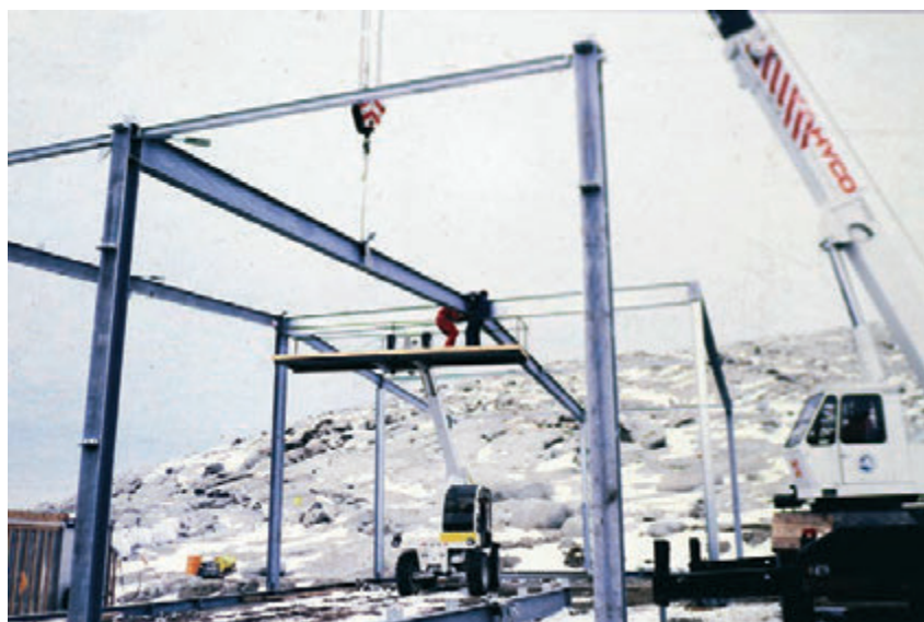
Stazione Mario Zucchelli, montaggio struttura metallica portante dell'hangar magazzino
