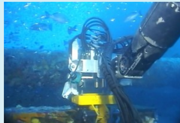
ROV檢測陽極塊使用狀況
