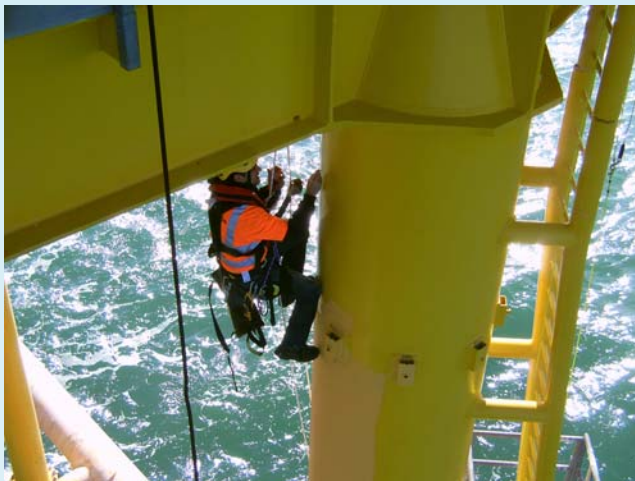
定期性塗裝檢測
