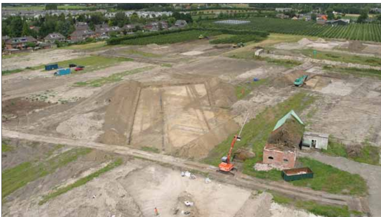
Afb 2.25 In 2004 is op De Woerd in De Meern de limesweg over een lengte van 200 m aaneengesloten onderzocht (wnr 10). Het meest in het oog springende element waren de bermgreppels, die aan beide zijden van de agger lagen. Deze bleken herhaaldelijk te zijn opgeschoond en opnieuw ingegraven. In de periode tussen het laatste kwart van de eerste eeuw tot en met het eerste kwart van de derde eeuw zijn vijf verschillende bermgreppelparen aangelegd. Op de foto staat vlak 2 van werkput 31 waarin het archeologisch restant van de verschillende bermgreppels aan beide zijden van de weg zichtbaar zijn.
