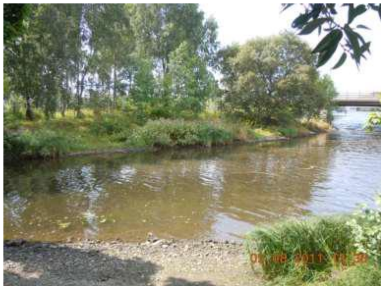
Bevuxet område med erosionsskydd strax öster om Marieholmsleden (foto taget mot väster).
