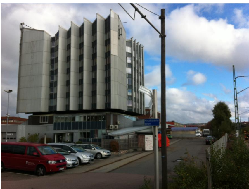
Byggnaden inom fastigheten Olskroken 35:17.
