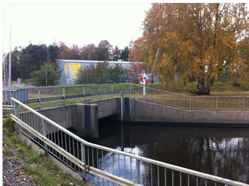
Gullbergsån går in i en kulvert under Partihandelsgatan.
