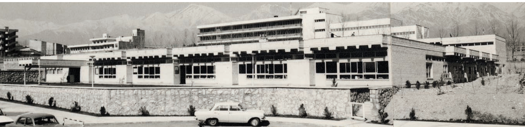
Le nouveau lycée Razi à Téhéran sort de terre en 1973.
