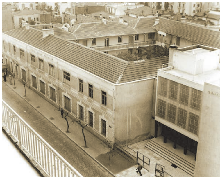
Le lycée de garçons de Thessalonique est reconstruit et devient également un centre culturel français, à droite de l'image (années 1946-1950).
