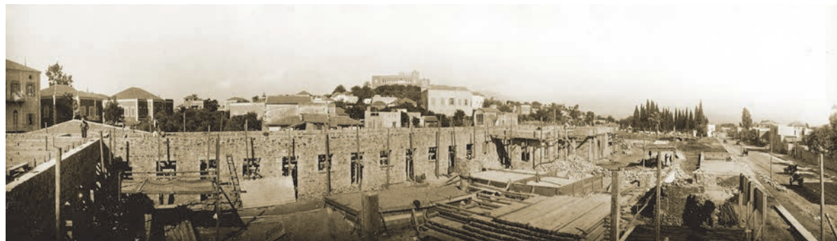
Construction du collège de Beyrouth (juin 1922).
