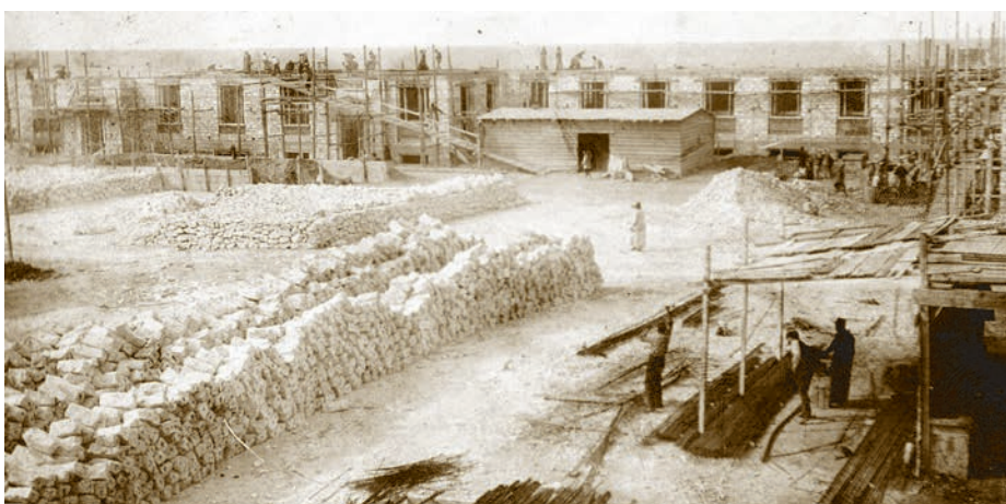
Chantier de construction du lycée d'Alexandrie (janvier 1914).
