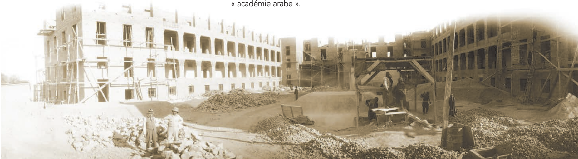
Chantier de construction du Lycée franco-arabe de Damas.
