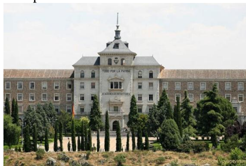
Fachada principal y uno de los patios
