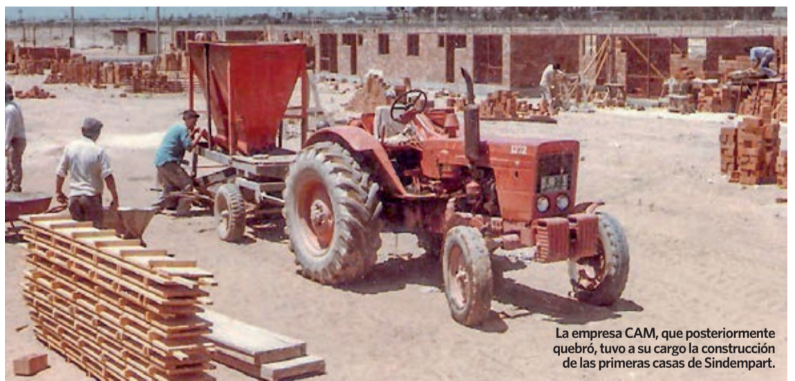
Los primeros cimientos para la construcción de la primera etapa de la cooperativa Sindempart, en terrenos que antes eran parcelas del sector Miramar. (Foto Hermán López)
