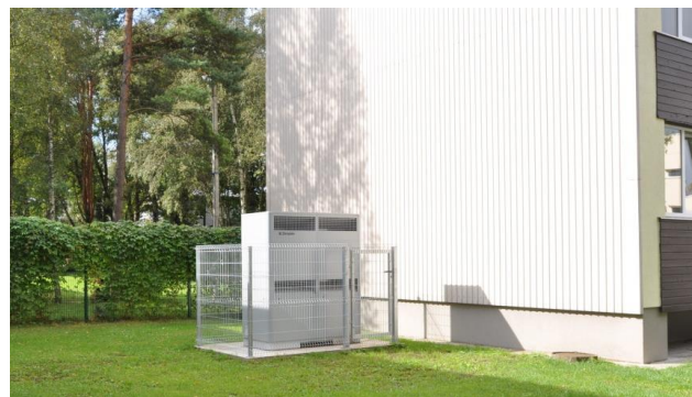
Joonis 6.12 Näiteid korterelamu õhk-vesi soojuspumpsüsteemi välisosadest ( www.airwave.ee ; ait-nord.ee ).
