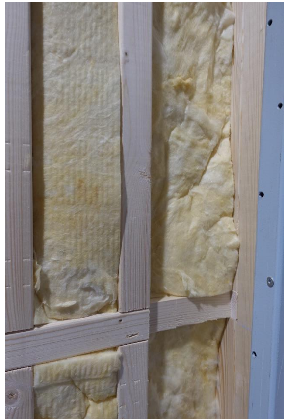
Joonis 4.8 Kui soojustuse paigaldamisel jäävad piirdetarindisse suuremal või väiksemal määral tühimikud, õhukanalid vms, siis need suurendavad piirdetarindi soojusläbivust. Vasakul hästi paigaldatud soojustus, paremal näide puudulikust kvaliteedist.
