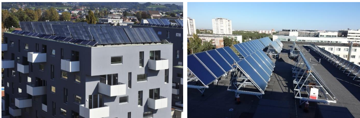
Joonis 7.2 Näide päikesekollektorite paigaldusest kortterelamu katusele.
