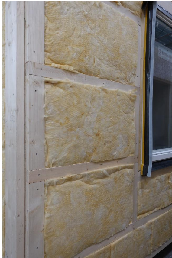
Joonis 4.8 Kui soojustuse paigaldamisel jäävad piirdetarindisse suuremal või väiksemal määral tühimikud, õhukanalid vms, siis need suurendavad piirdetarindi soojusläbivust. Vasakul hästi paigaldatud soojustus, paremal näide puudulikust kvaliteedist.
