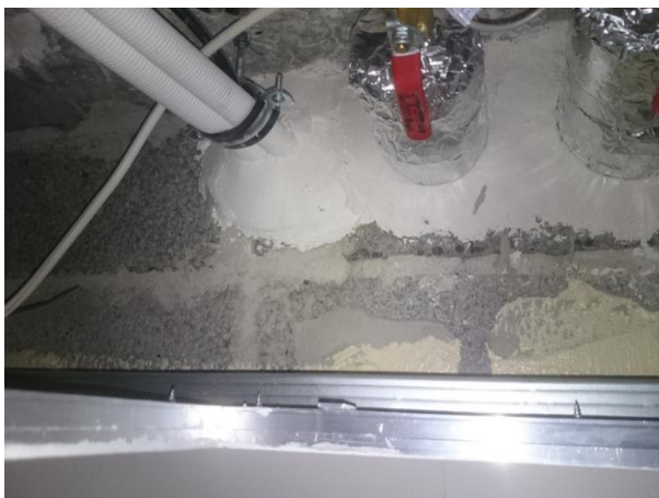
Joonis 4.3 Sein tuleb krohvida kogu ulatuses, mitte ainult kuni ripplaele. Krohvimistööd tuleb teha kohe pärast müüri ladumist.
