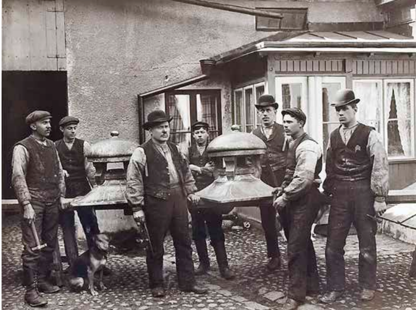
Plåtslagare vid J A Rosenson & Söners Plåtslageri AB i Uppsala visar upp kröndetaljer som de drivit fram ut kopparplåt. Bilden, som är tagen 1908, finns hos Upplandsmuseet.
