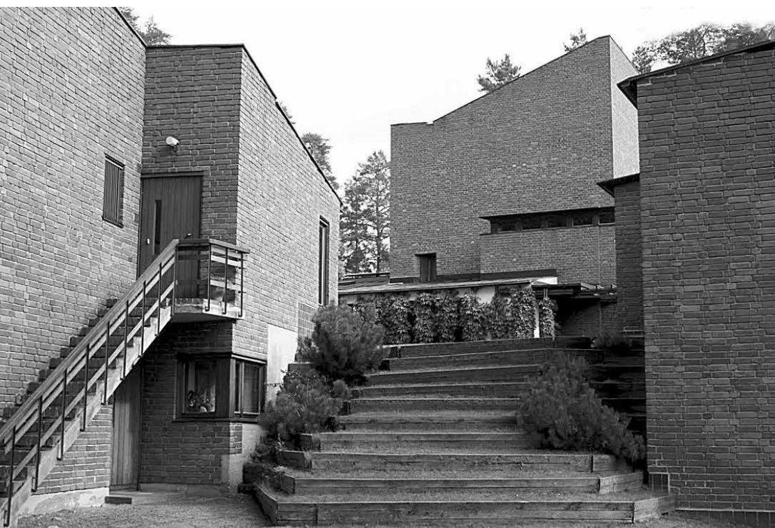
Сградата на общината в Saynatsalo. Архитект: Алвар Аалто. Източник: homesthetics.net
