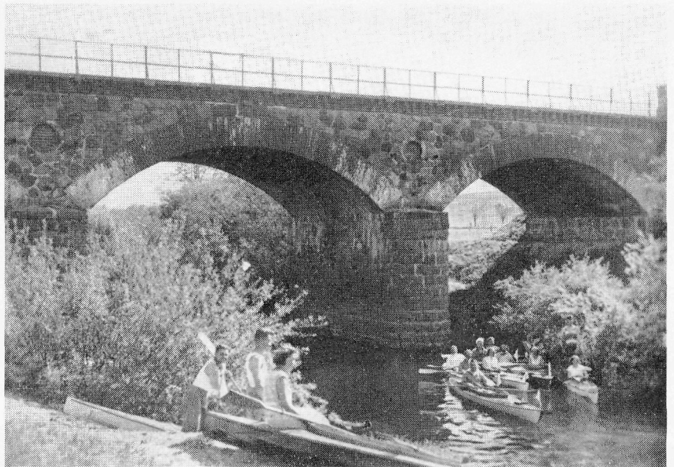
Unter der Ekkitterer Brücke
