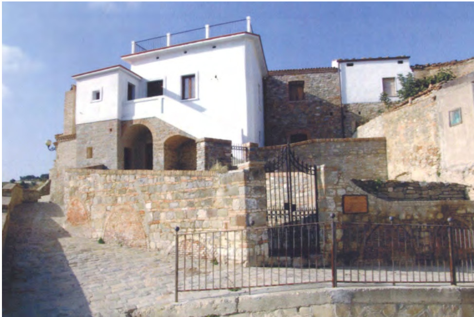
Casa di confino d'Aliano, habitada entre 1935 i 1936 per l'escriptor Carlo Levi.
