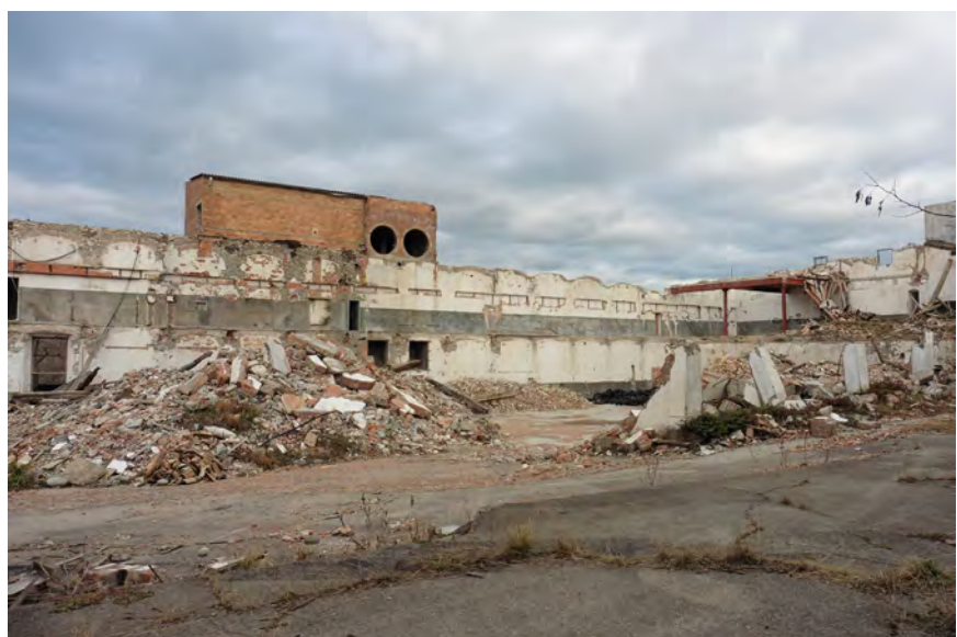
Aspecte actual d'una part de les fàbriques de Gallifa (2014).
