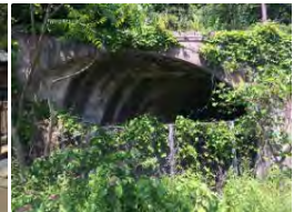
廃坑となった未利用のトンネル
