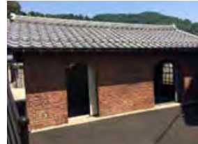
写真：ランプ小屋
