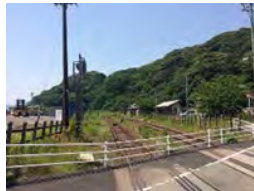
写真：ランプ小屋へは大きく迂回が必要
