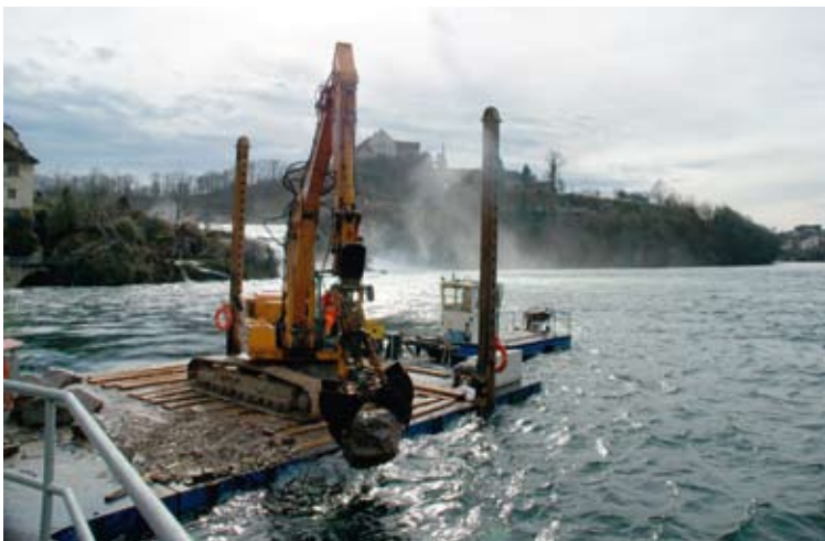
Der Greifer hat den Stein gepackt und lässt ihn nun in der Tiefe verschwinden. Es gibt dort Stellen, die unterspült sind.
