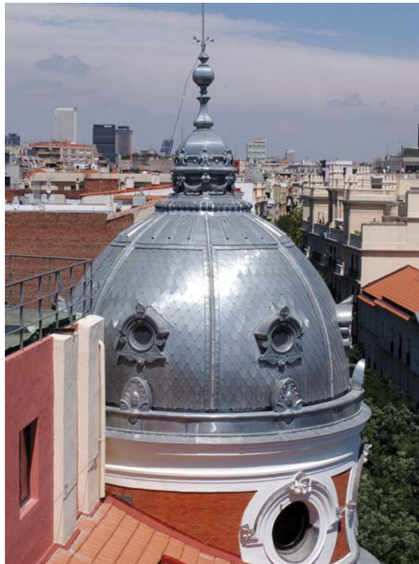
Cúpula de la torre norte.
