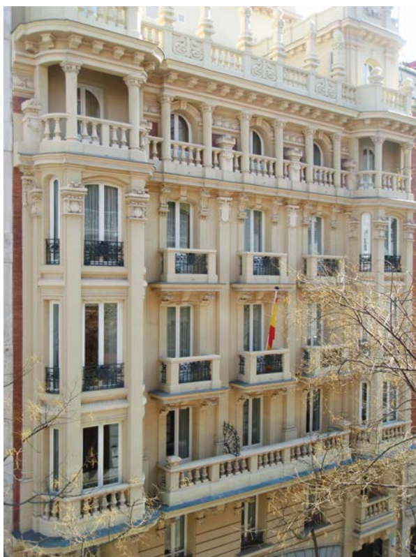
Ministerio del Interior (calle Amador de los Ríos, 8).
