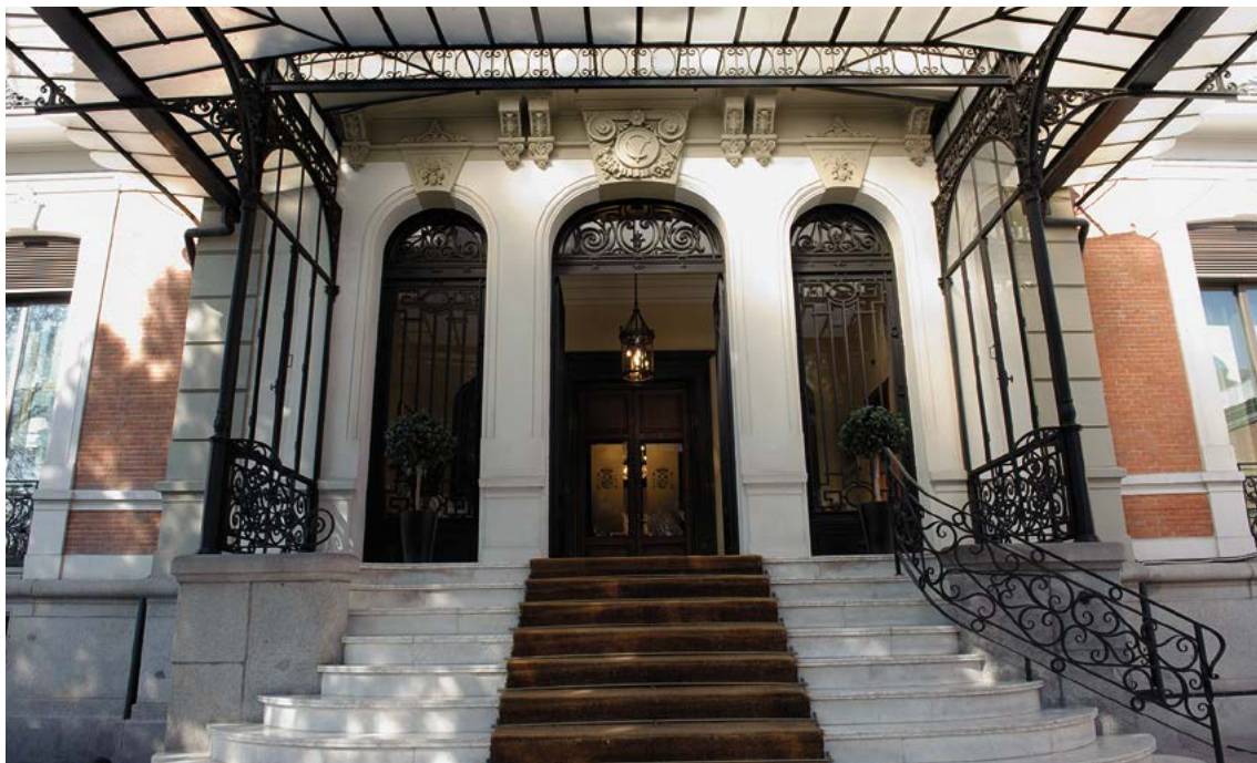
Escalera y puertas principales, donde se aprecia el escudo de Casa-Valencia.
