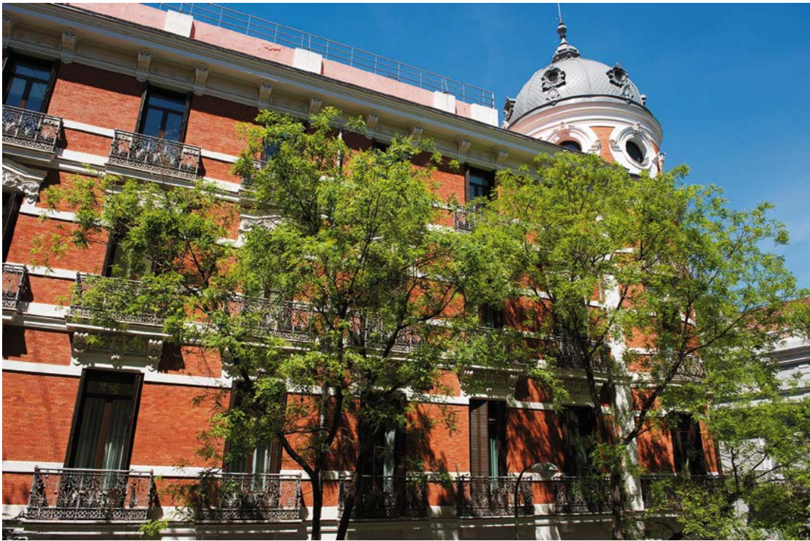
Vista de la fachada y de la torre norte.
