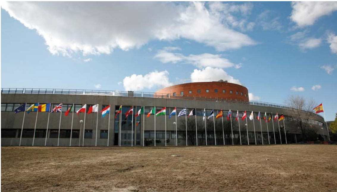
Escuela Nacional de Protección Civil (Rivas-Vaciamadrid). 2008.
