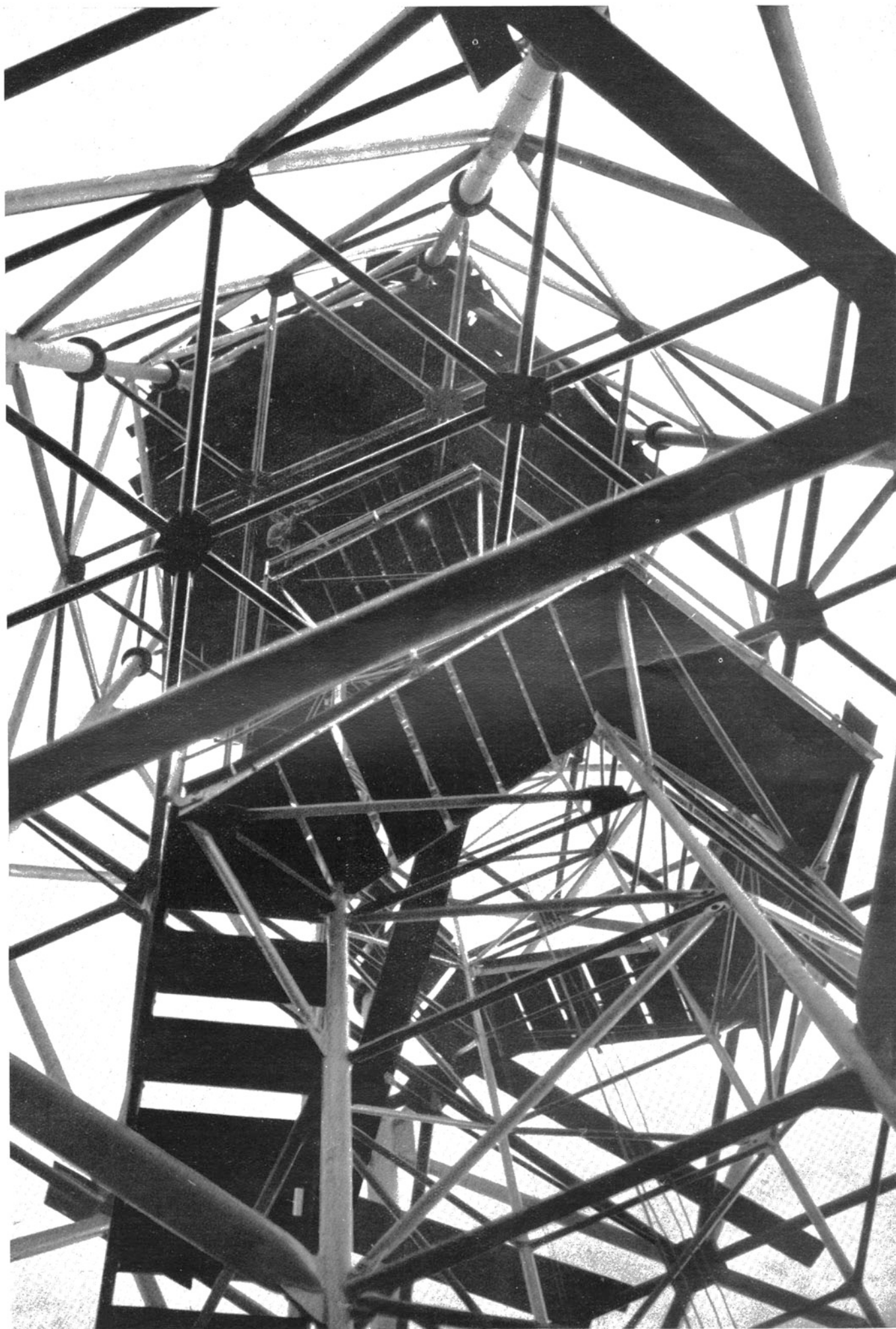
UN ASPETTO DELLA TORRE LITTORIA DURANTE I LAVORI DI COSTRUZIONE
