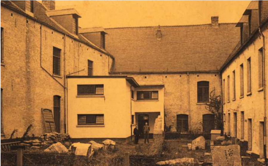
L'annexe construite par Henry Van de Velde à l'angle de l'ancienne infirmerie et des communs, vers 1930 (IGN).
