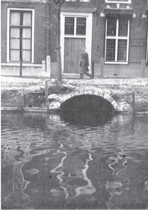
Afb. 6. De overkluizing van de Roomgracht in 1948 bij het vernieuwen van de walmuur van het Rapenburg. Foto C.H. van Ulden, Leids Jaarboekje 1950.
