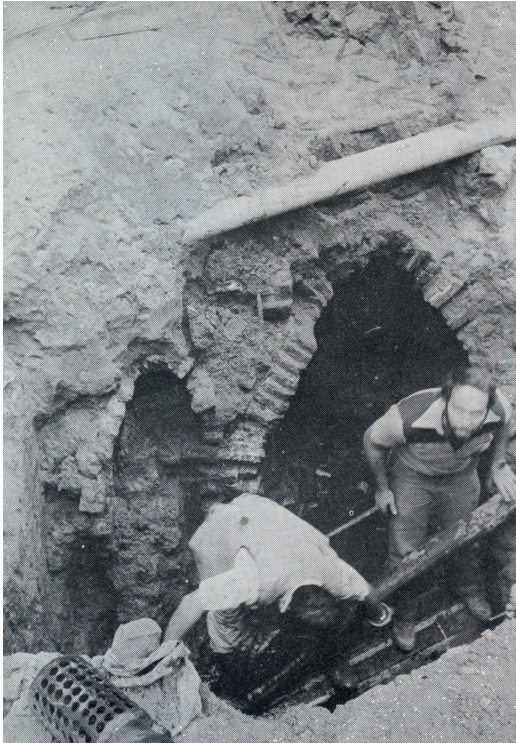
Afb. 36. De Dollhuisgracht bij de rioleringswerkzaamheden in 1982. Foto mr. ir. L. Barendregt.
