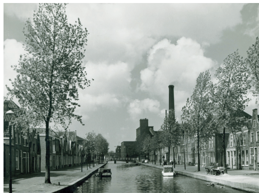
Afb. 40. De Langegracht van de Houtmarktbrug naar het westen gezien. Foto 1957. (ELO) Vanaf het punt waar u nu staat is dit het stuk van de Langegracht aan uw rechterhand. Op de foto rechts op de achtergrond de Stedelijke Lichtfabrieken, waar u nu tegenover staat.
