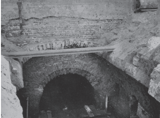
Afb. 9. Overkluizing van de Leidse Vliet in het verlengde van de Papengracht onder de Vierschaar van het Gravensteen, bij de demping en vervanging door een riool in 1956. Foto W.J. van Varik. (ELO)
