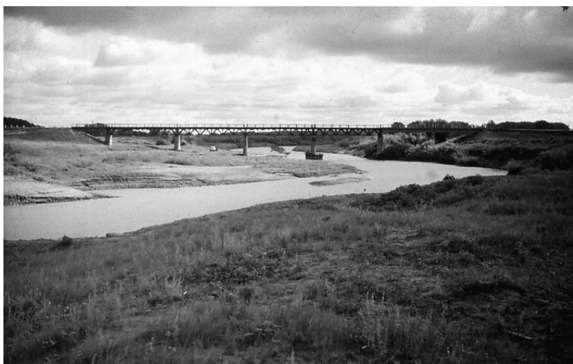
Рис. 9.17. Мост на р. Алея, находящийся в аварийном состоянии вследствие развития излучины.
