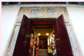
公所的花崗石門框刻有建築年份（清同治元年，即1862年） Historic granite doorframe of Kung Sor showing the construction year (the 1 st year of the Tongzhi reign of the Qing dynasty, 1862)
