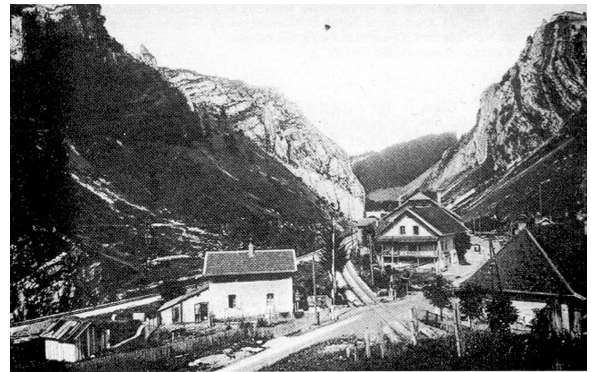
In Le Frambourg zweigte die „Jougne-Linie“ (links im Bild) von der „Franco-Suisse“ (rechts im Bild) ab. Von der ehemaligen Linie nach Vallorbe zeugt an dieser Stelle heute noch ein grosser Einschnitt. Sammlung BAILLY.
