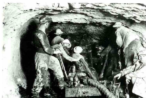
Vortriebsarbeit mit Meyersche Druckluft-Stossbohrmaschinen im Grenchenbergtunnel. Bild: Stadtarchiv Grenchen.
