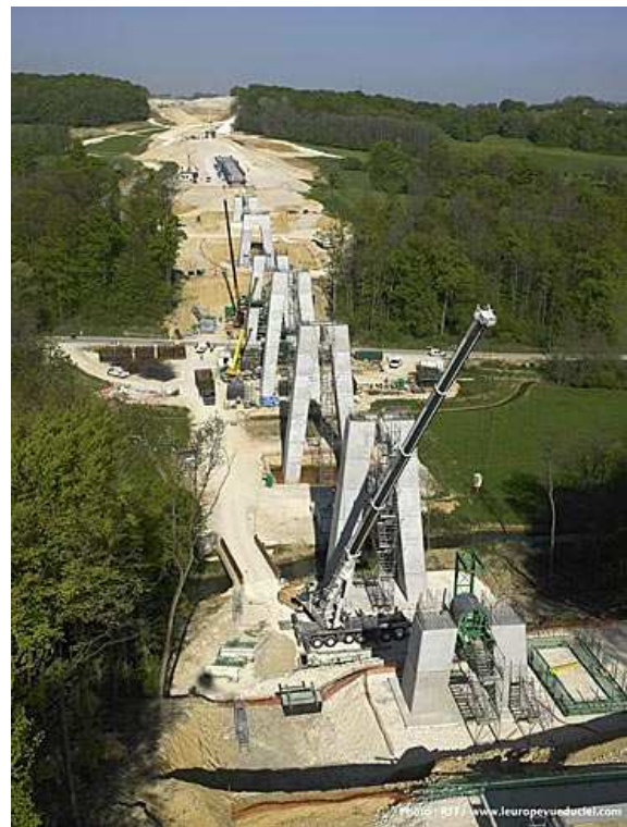
Der Viadukt „La Linotte-Ormenans“ im Bau. Inzwischen wurden die hier noch fehlenden Brückenelemente montiert. Foto © RFF.
