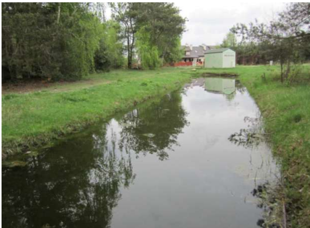
Fot. 250. Rów rozsączająco-odparowujący zbierający wody z północnej części ul. Grechuty. (MM)
