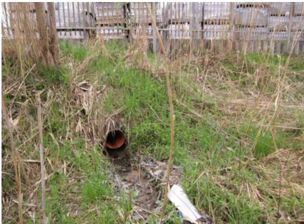
Fot. 252. Ujście rury PCV odprowadzającej wody z terenu zakładu produkcji kostki brukowej "JADAR". (MM)
