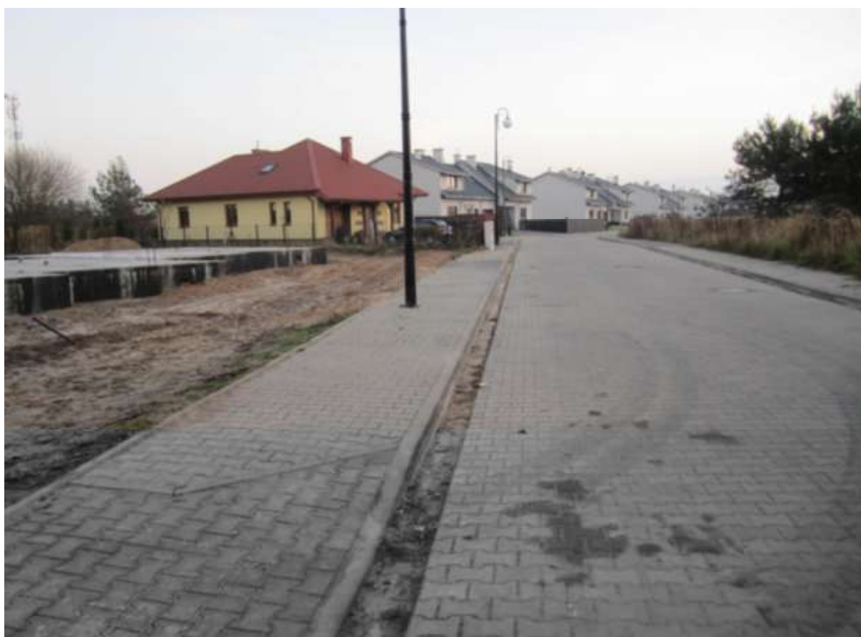
Fot. 228. Zabudowa wzdłuż ul. Grechuty szczelnie zamknęła „ścianę wschodnią” użytku ekologicznego „Bagno”. (MM)
