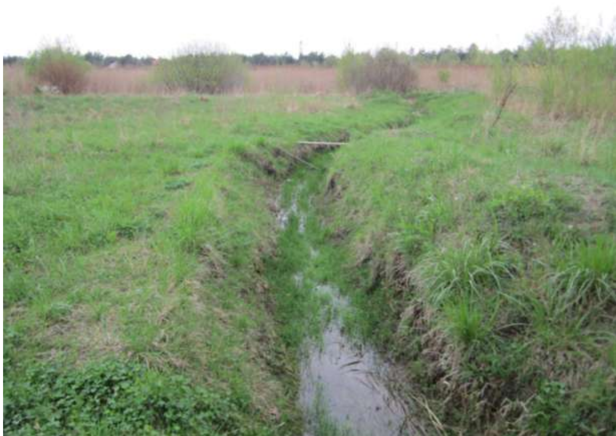
Fot. 248. Rów odprowadzający pomiędzy rowem rozsączająco-odparowującym, a użytkiem ekol. (MM)
