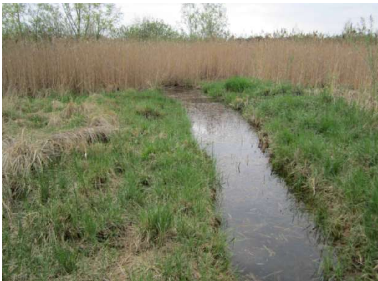
Fot. 249. Rów odprowadzający pomiędzy rowem rozsączająco-odparowującym, a użytkiem ekologicznym. (MM)
