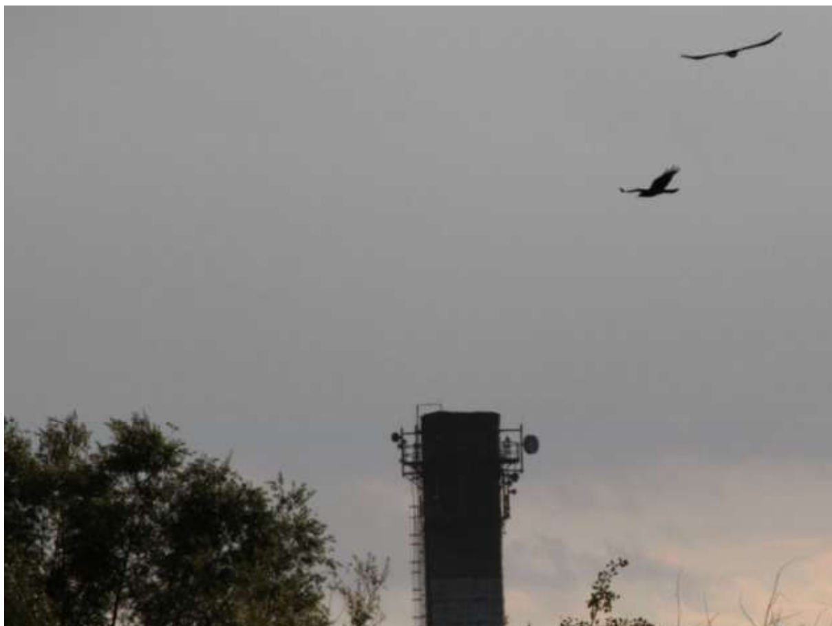
Fot. 6. Komin ciepłowni przy ul. R. Ziętałów dominuje w krajobrazie w kierunku zachodnim. (MM)
