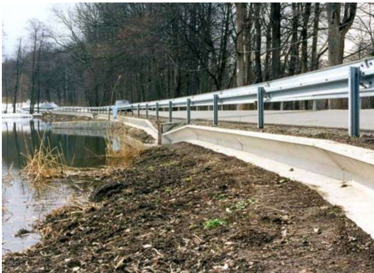
Fot. 256. Przykład betonowego ogrodzenia ochronnego dla pławów. (źródło: pracownia.org.pl )
