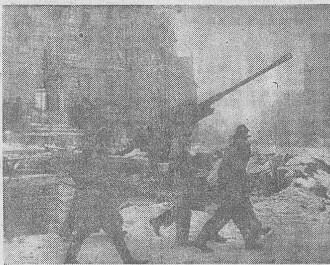
A győzelmes felszabadító harcok során a szovjet katonák kisöpörték a romhalmazzá vált fővárosból a fasiszta hordákat. A mai Móríz Zsigmond körtér siralmas látványt nyújtott.
