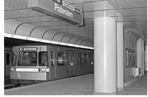
Fertigstellung der U-Bahn-Linie U1, zugleich Fertigstellung des U-Bahn-Grundnetzes
