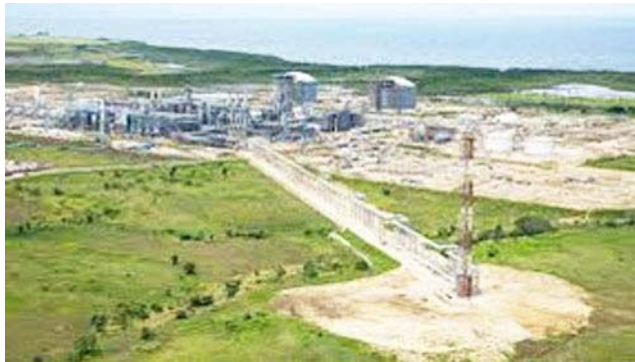
Caution Bay LNG Plant
