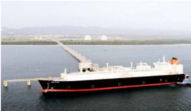
Caution Bay LNG Terminal
