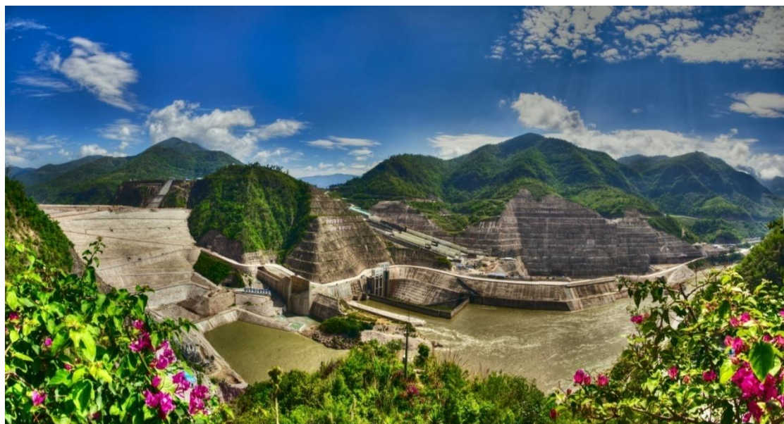
图6.3: 坝式水电站示例-糯扎渡水电站
