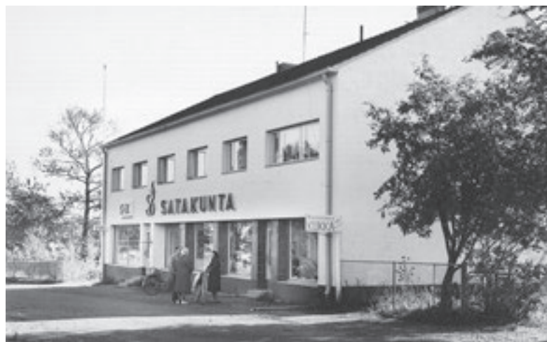
Reposaaren uusi kaksikerroksinen myymälärakennus valmistui keväällä 1953
