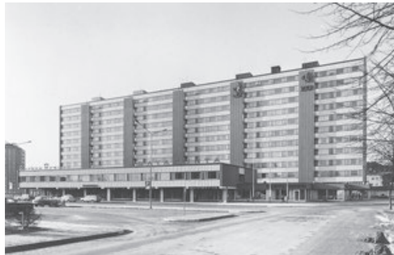
Osuuskaupan toinen hotelli Karhun Kruunu avattiin 1963 Porin Keskuskartano-kiinteistön matalassa osassa. Keskuskartano oli valmistuessaan Pohjoismaiden suurin vuokratolokiinteistö.
