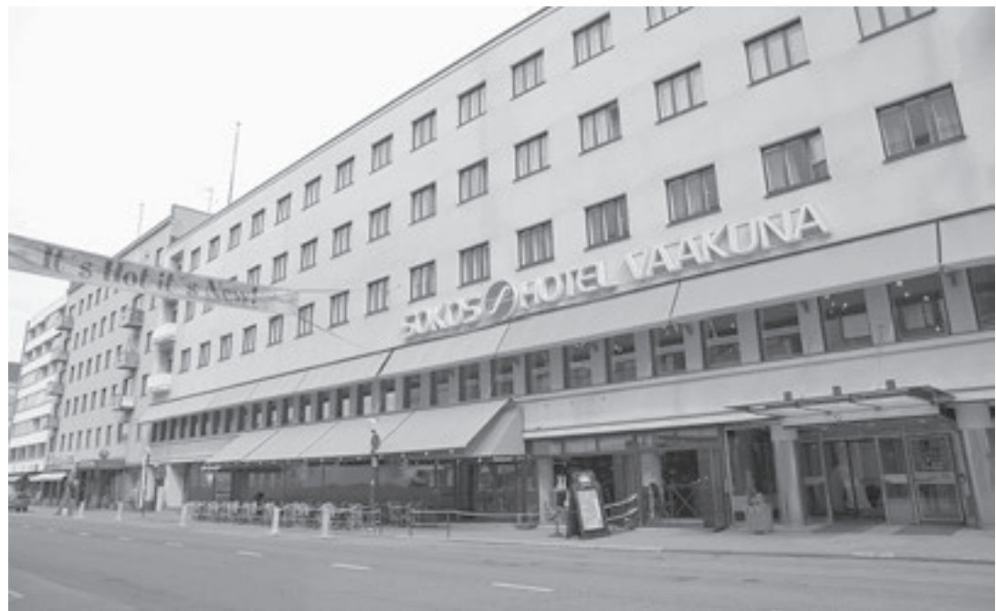
Satakunnan Osuuskaupan päätoimitalo ja hotelli Satakunta 1950-luvulla. Oikealla talo Sokos Hotel Vaakunan ja ravintoloiden käytössä vuonna 2007.
