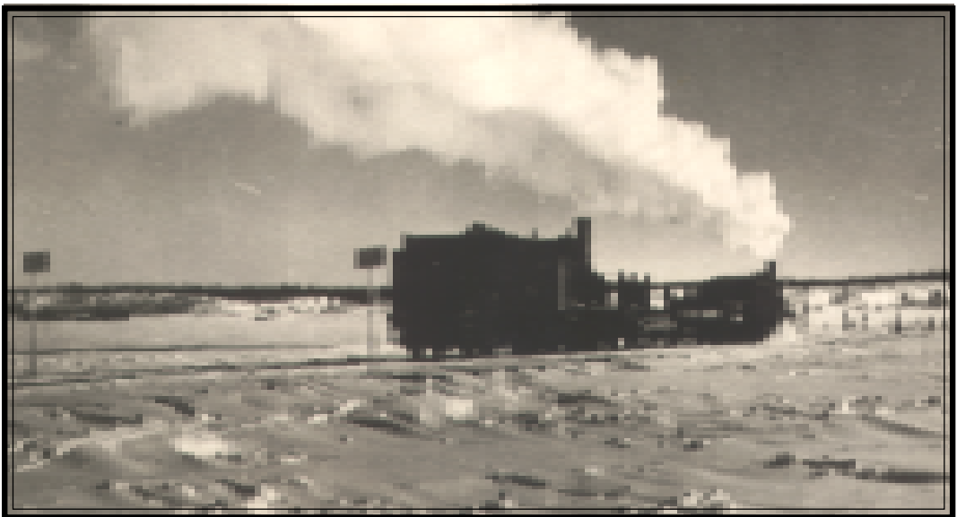
Перевозка на правый берег реки Б. Обь паровоза серии О в (в холодном виде) тягой паровозом той же серии под прикрытием платформ (ГА ЯНАО. Ф. 92. Оп. 3. Д. 181. Л. 75)
