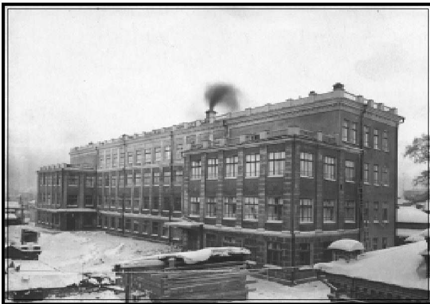
Школа № 9, ул. 9-го Января, 51-а, главный фасад.
