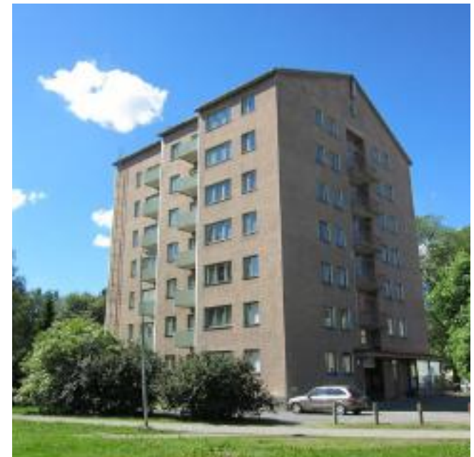
Kiertokatu 14 (yllä) ja Kiertokatu 12 (alla).
