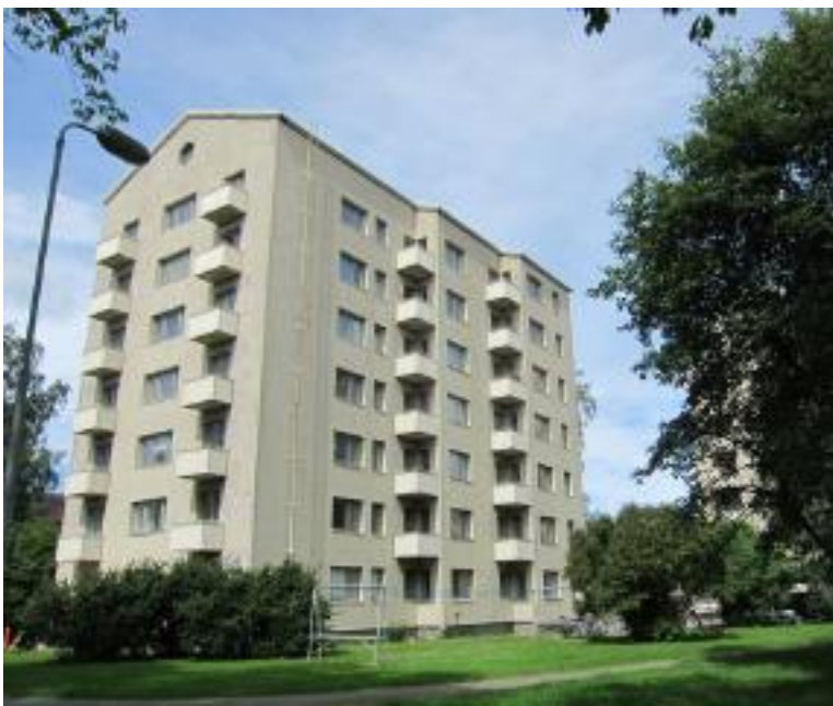
Kiertokatu 16 (yllä) ja Kiertokatu 18 (alla).
