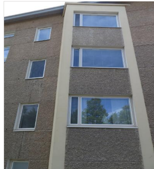
Rautatienpuistokatu 6-12 katujulkisivua (yllä). Erkkeri Rautatienpuistokatu 6:n katujulkisivulla (alla).
