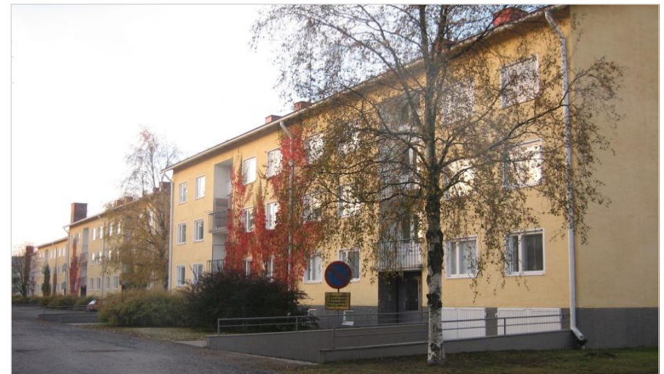
Kiertokatu 9, 7 ja 5 pihajulkisivua. Kuva: Liisa Nummelin 2008, Satakunnan Museo.
