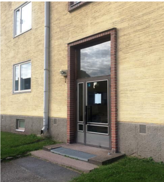
Alkuperäinen jalopuinen ulko-ovi vuodelta 1954 (yllä) ja uusittu metallirakenteinen ulko-ovi 1980-luvulta (alla).
