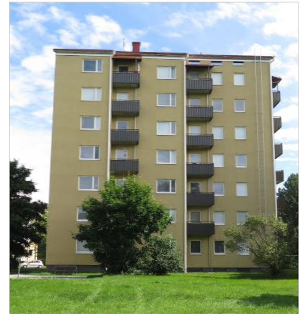
Kiertokatu 6 (yllä) ja Kiertokatu 4 (alla).
