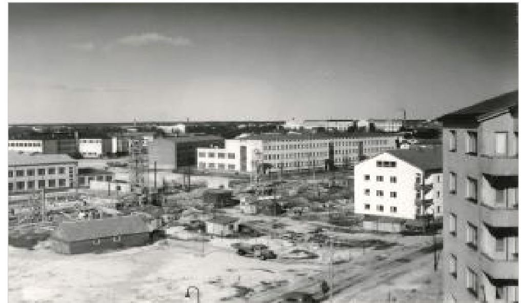
Kiinanmuurin rakennustyöt käynnissä Rautatiepuistokadulla (yllä) ja Rautatiepuistokadun työmaata (alla) 1950-luvun puolivälissä. Kuvat: Satakunnan Museo.
