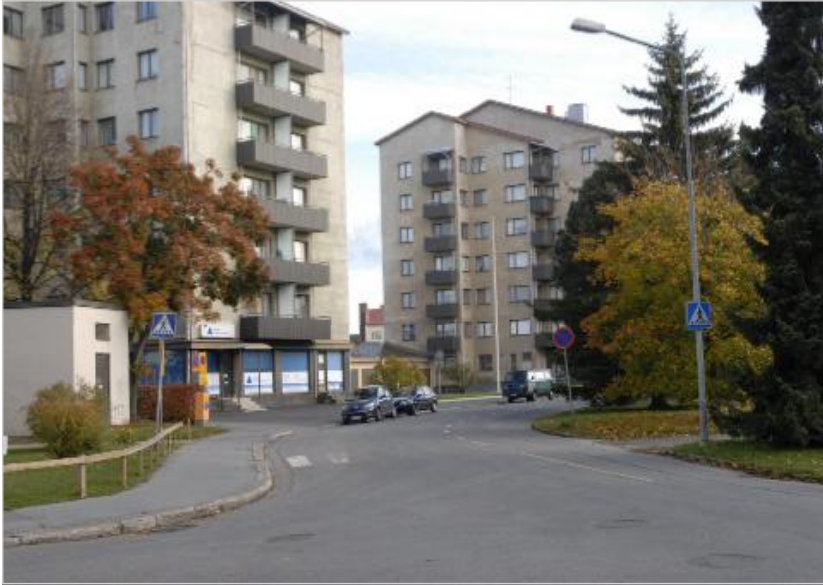
Kiertokatu 15 ja 13 katujulkisivua vuonna 2008, ennen vuoden 2010 mittavaa julkisivuremonttia. Kuva: Pentti Pere, Satakunnan Museo.
