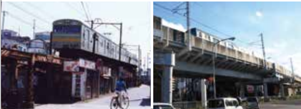
左)昭和52年ころの南町付近 右)塩釜線が高架で仙石線に乗り入れできるように準備された橋台(南町付近)
