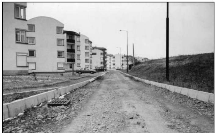
Na snímke časť komunikácií čakajúcich na povrchovú úpravu.
