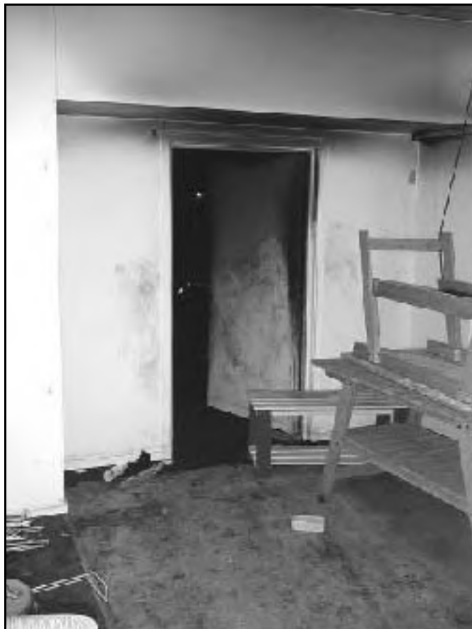
Bild 17 Den nyligen installerade brandcellsavskiljningen mellan klädavdelningen och grannfastigheten.
