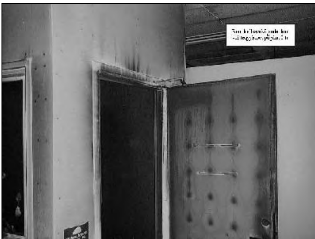
Bild 6 Brandcellsavskiljande dörrparti mot rulltrappa till markplan.
