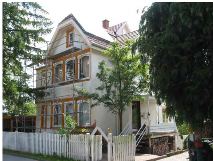
Ansicht des Gebäudes von Westen
