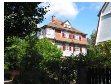
Ansicht des Gebäudes von Südosten
