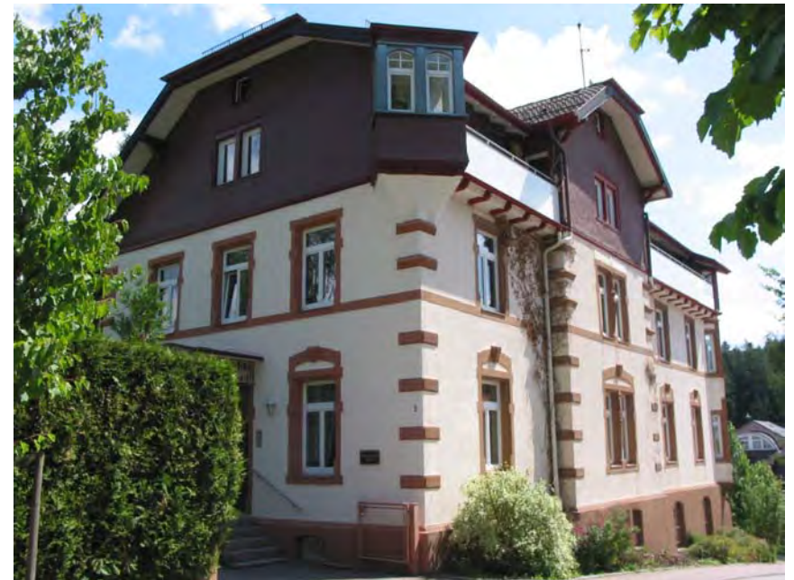
Ansicht des Gebäudes von Westen
