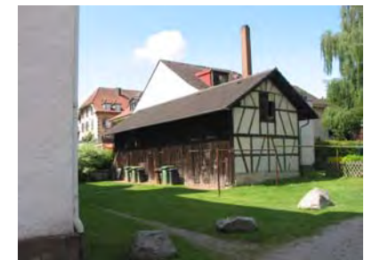
Ansicht des Nebengebäudes von Nordosten
