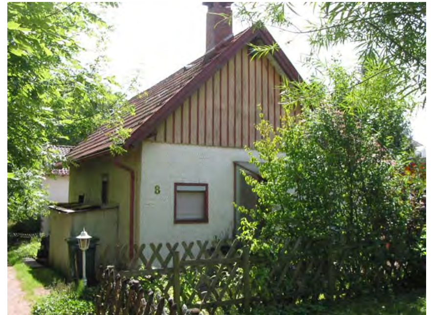
Ansicht des Gebäudes von Nordwesten
