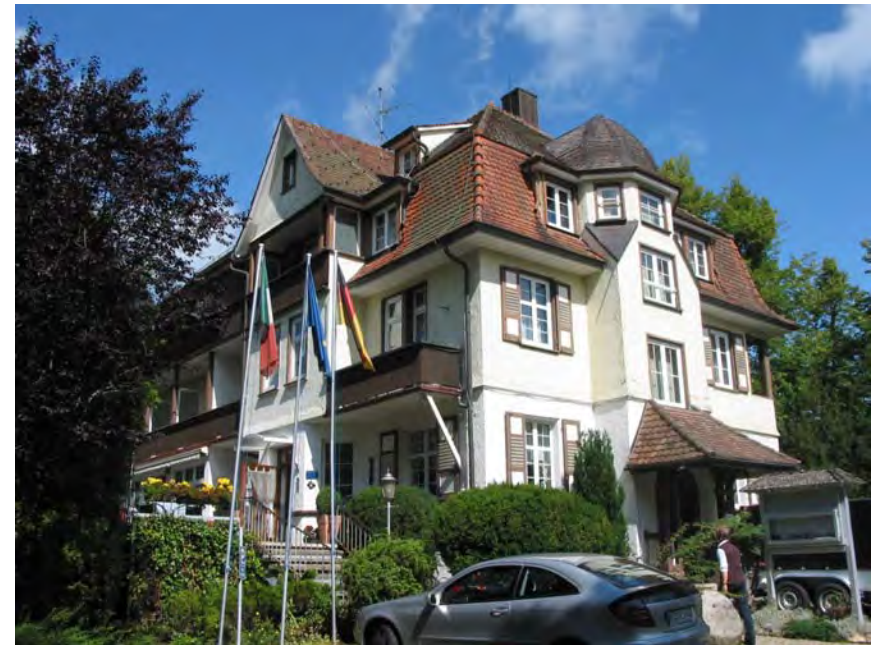
Ansicht des Gebäudes von Südosten
