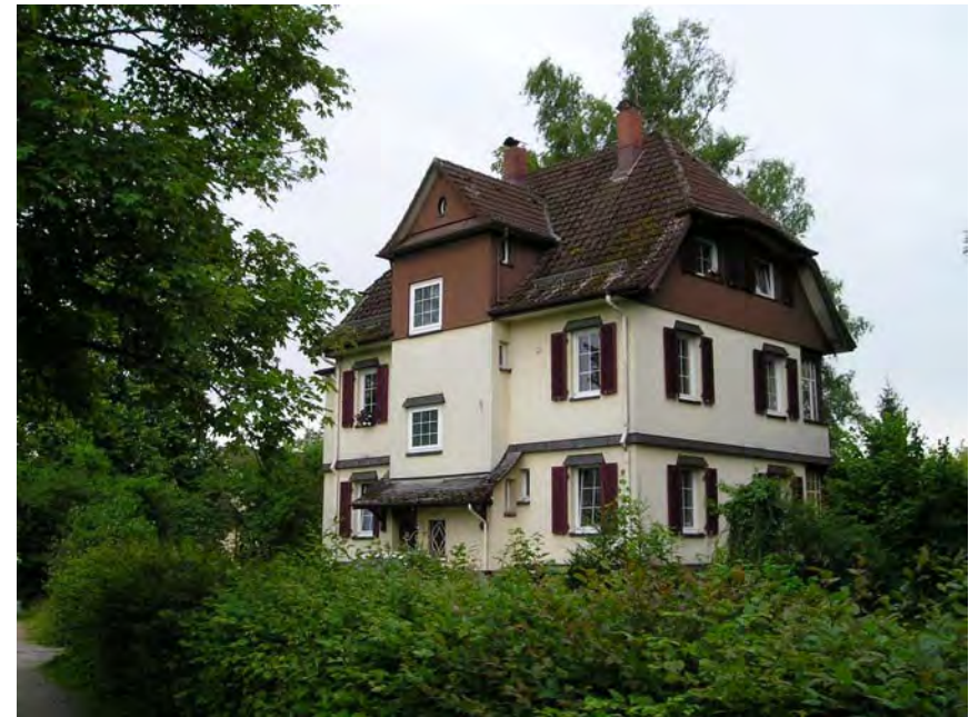
Ansicht des Gebäudes von Nordwesten
