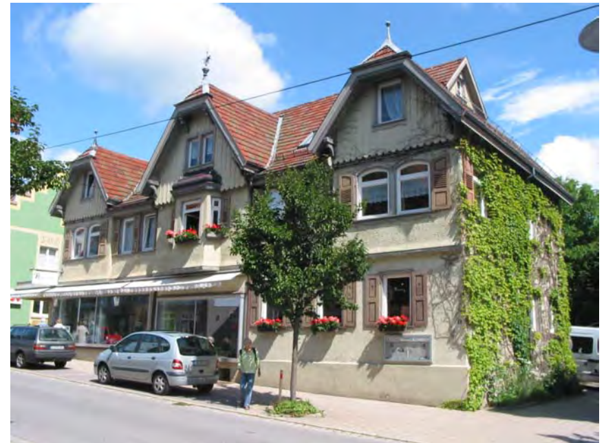
Ansicht des Gebäudes von Südosten
