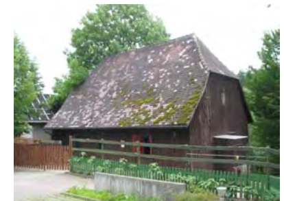
Ansicht des Nebengebäudes von Westen
