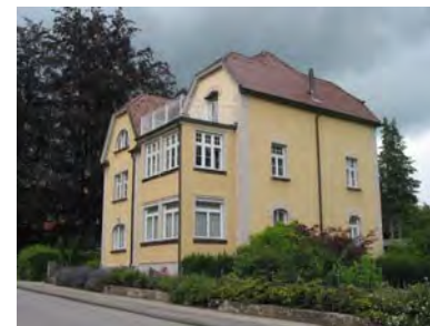
Ansicht des Gebäudes von Südosten
