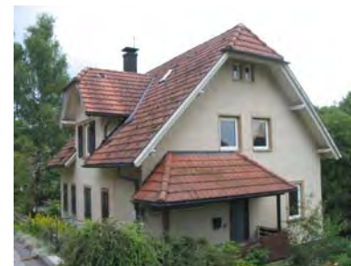
Ansicht des Gebäudes von Westen
