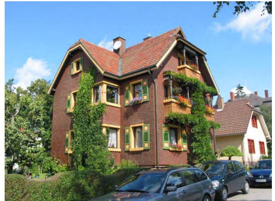
Ansicht des Gebäudes von Südosten
