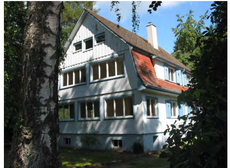
Ansicht des Gebäudes von Südosten
