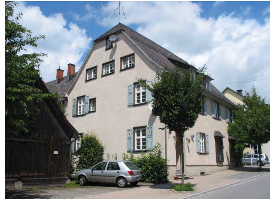
Ansicht des Gebäudes von Südosten
