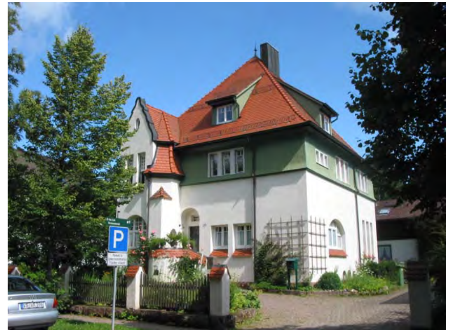
Ansicht des Gebäudes von Südosten
