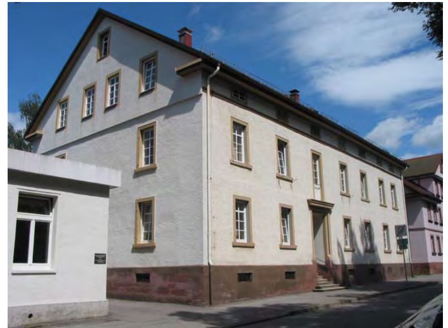
Ansicht des Gebäudes von Südosten
