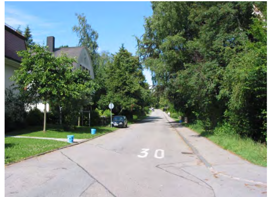
Blick nach Westen auf Höhe der Kreuzung Bodelschwingweg
