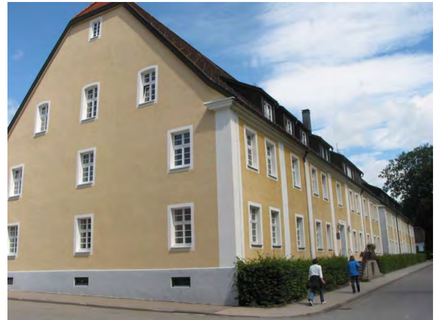
Ansicht des Gebäudes von Südosten
