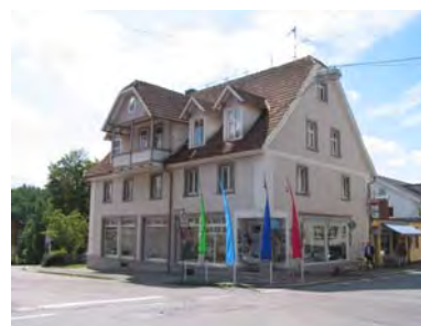
Ansicht des Gebäudes von Nordwesten
