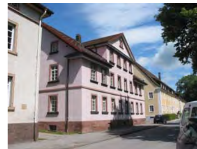
Ansicht des Gebäudes von Südosten
