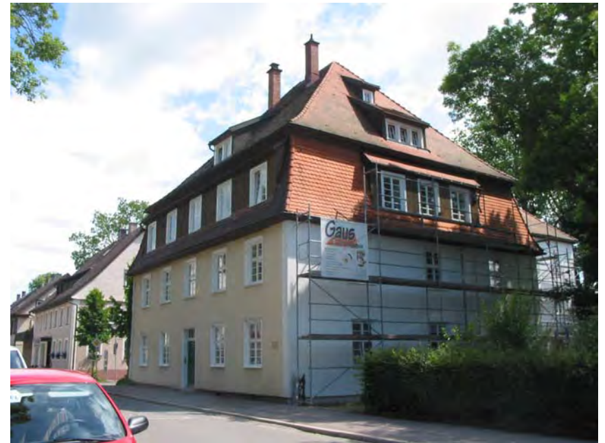
Ansicht des Bruderhauses von Südwesten
