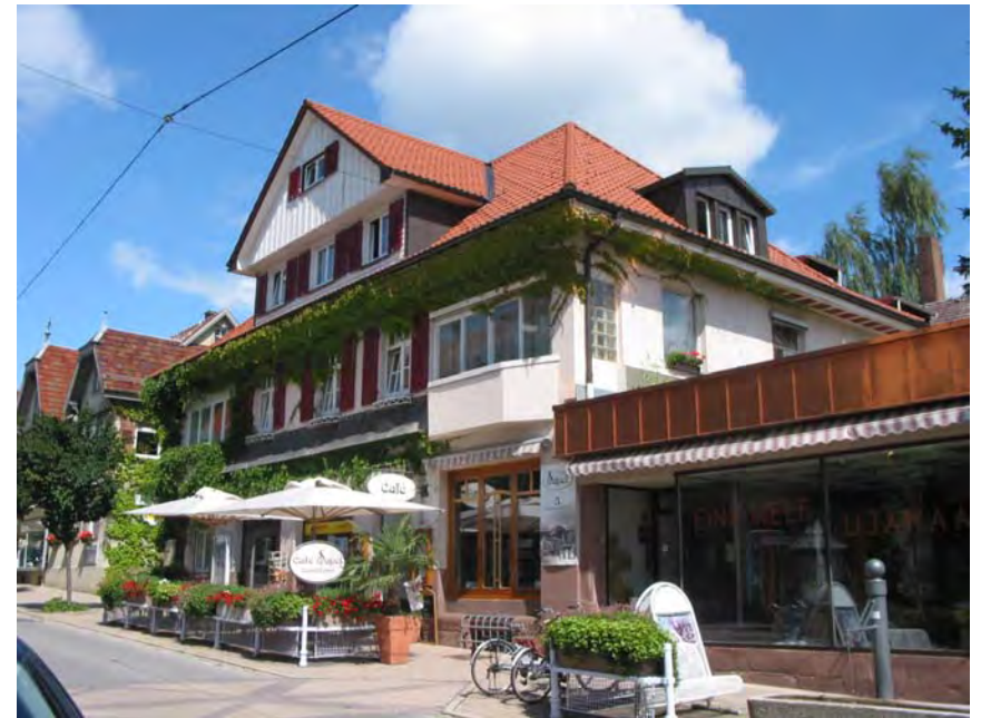
Ansicht des Gebäudes von Südosten
