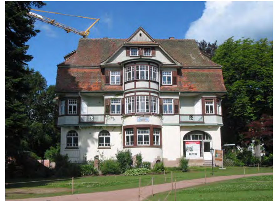
Ansicht des Gebäudes von Osten
