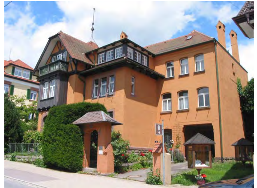
Ansicht des Gebäudes von Südosten
