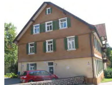
Ansicht des Gebäudes von Westen
