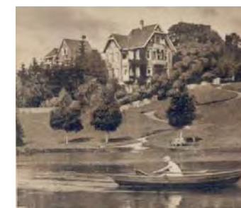
Ansicht des Gebäudes 1931
