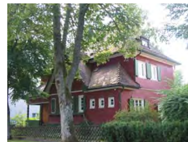
Ansicht des Gebäudes von Nordwesten
