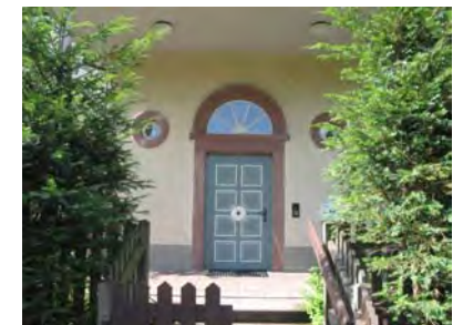
Ansicht der Hauseingangstüre
