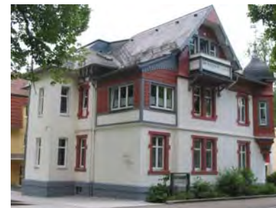
Ansicht des Gebäudes von Nordwesten
