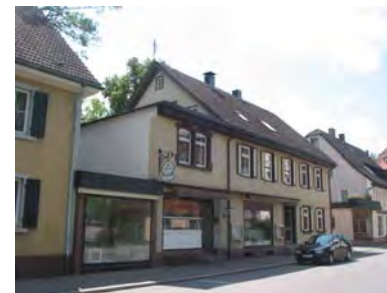
Ansicht des Gebäudes von Nordwesten
