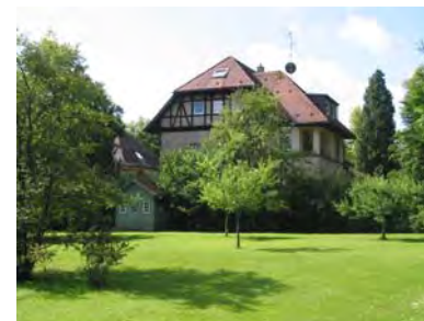
Ansicht des Gebäudes von Nordwesten
