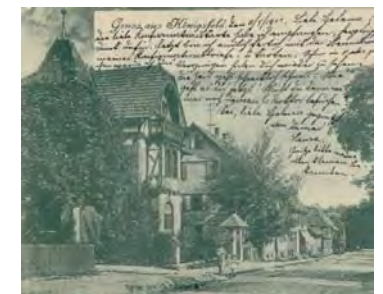
Ansicht des Gebäudes 1902
