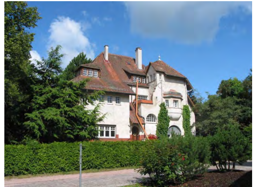
Ansicht des Gebäudes von Südosten
