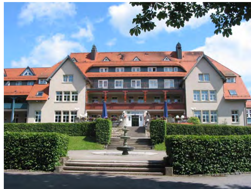
Ansicht des Haupthauses Nr. 1 von Süden
