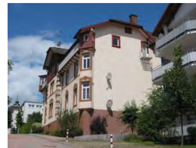
Ansicht des Gebäudes von Südosten
