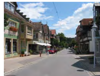
Blick nach Osten auf Höhe von Friedrichstraße 11
