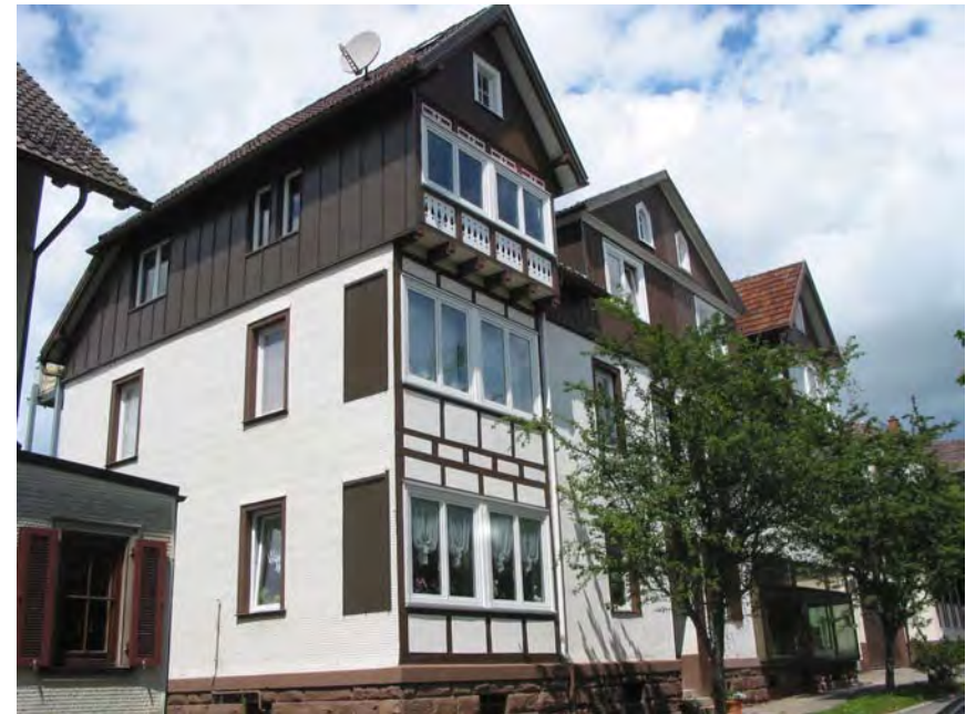
Ansicht des Gebäudes von Südosten
