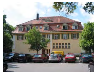
Ansicht des Gebäudes von Norden
