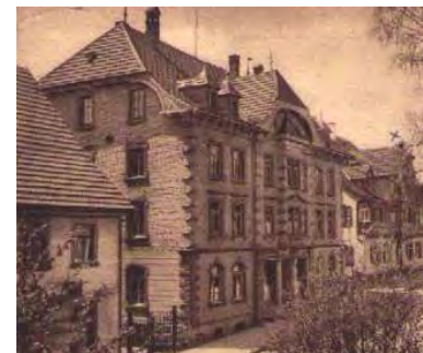
Ansicht des Gebäudes 1925
