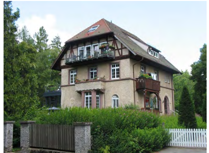
Ansicht des Gebäudes von Südosten
