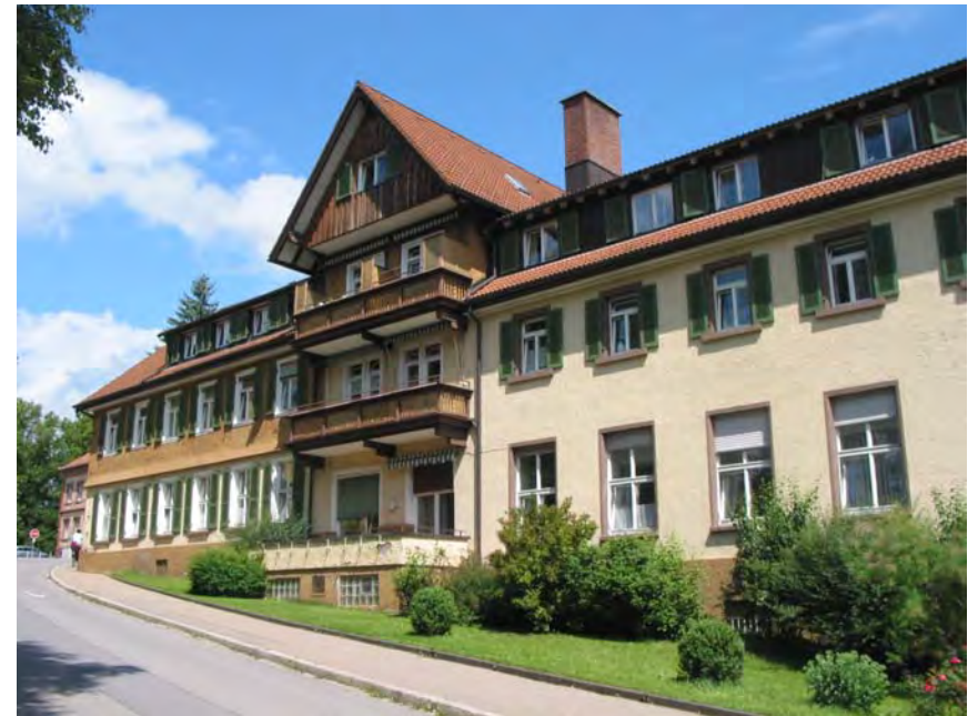
Ansicht des Gebäudes von Südosten
