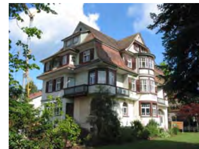
Ansicht des Gebäudes von Südosten
