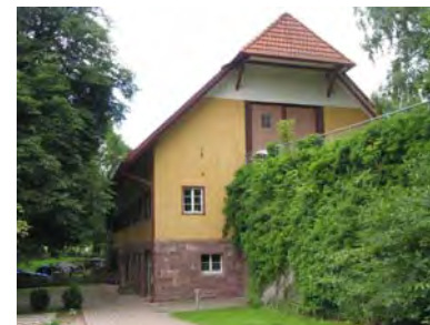
Ansicht des Hörnlishofs von Nordosten
