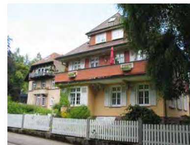
Ansicht des Gebäudes von Südosten
