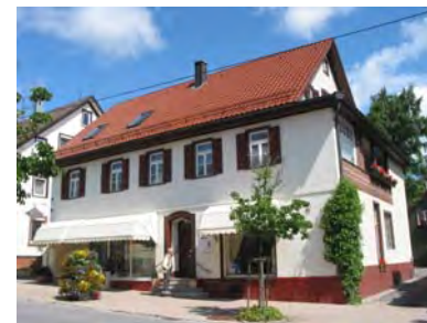
Ansicht des Gebäudes von Südosten
