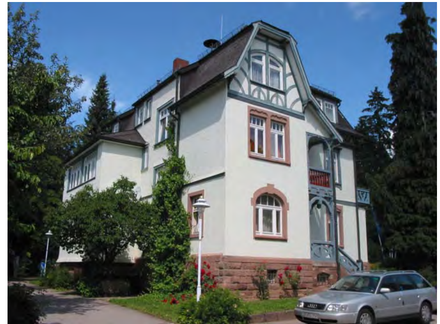
Ansicht des Gebäudes von Südosten
