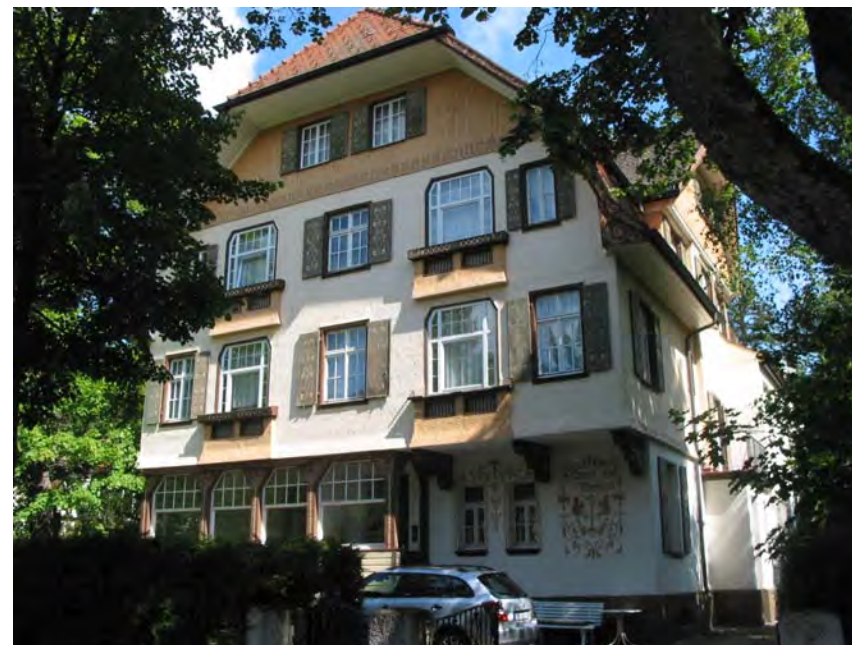
Ansicht des Gebäudes von Südosten
