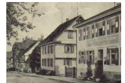
Ansicht des Gebäudes 1916
