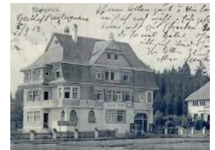
Ansicht des Gebäudes 1913
