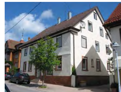
Ansicht des Gebäudes von Südosten
