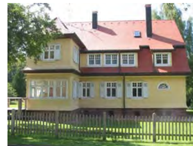
Ansicht des Gebäudes von Südosten
