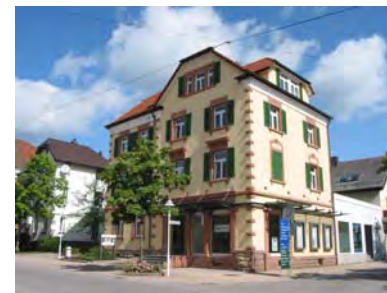
Ansicht des Gebäudes von Südosten
