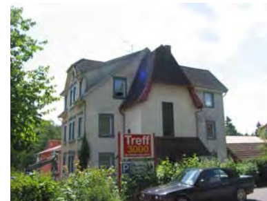
Ansicht des Gebäudes von Nordwesten
