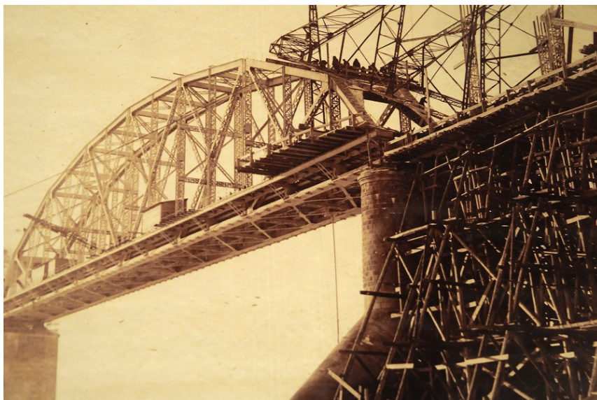
Ил. 3. Буреинский мост Амурского участка Сибирской железной дороги. Фотография начала XX в.
