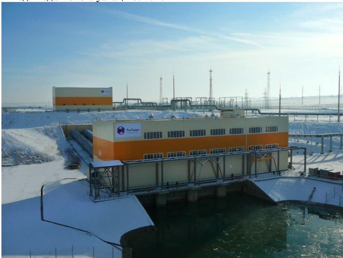
Ил. 6. Егорлыкская ГЭС
