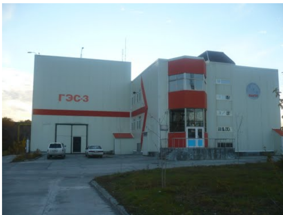
Ил. 5. Здание Толмачевской ГЭС
