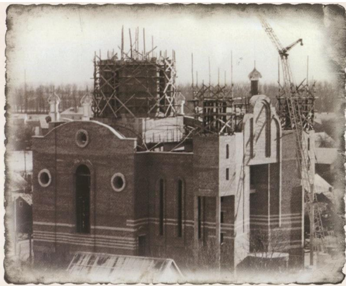
Будівництво храму. Фото 1999р.
